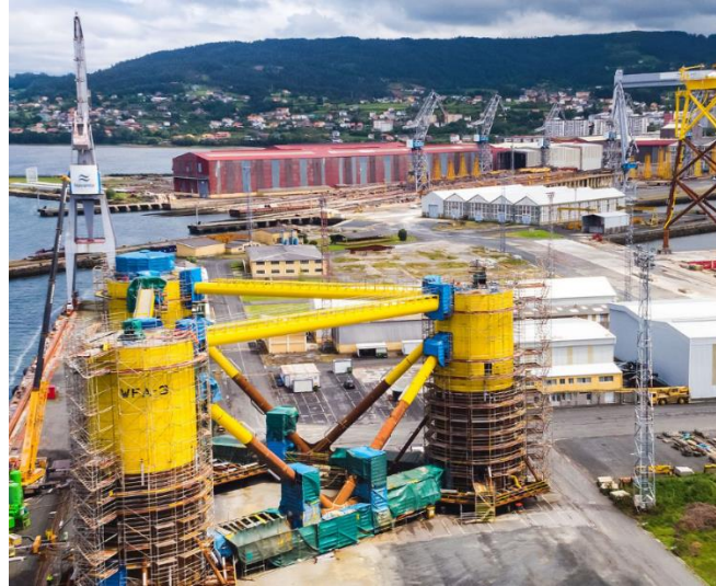
Figura 50. Plataforma semi-sumergible WindFloat en un espacio dedicado a su construcción al lado del puerto. Fuente (PrinciplePower, 2022).
