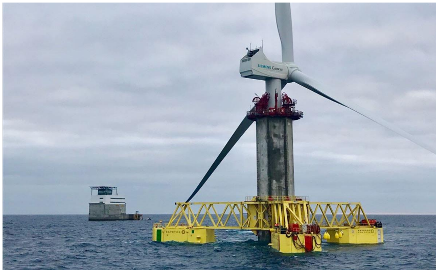
Figura 5. Primer aerogenerador instalado en España. Fuente (xataka.com, 2018).
