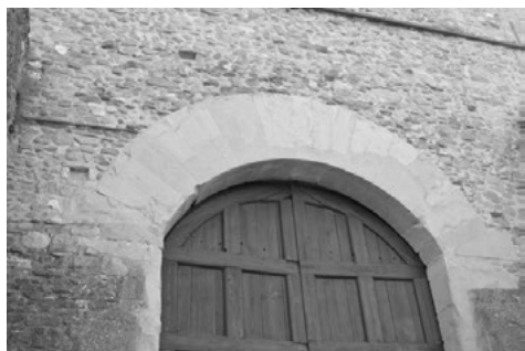
Fig. 5. Portal of Palazzo dei Vicari in Scarperia (Source: Bordini, 2021)
