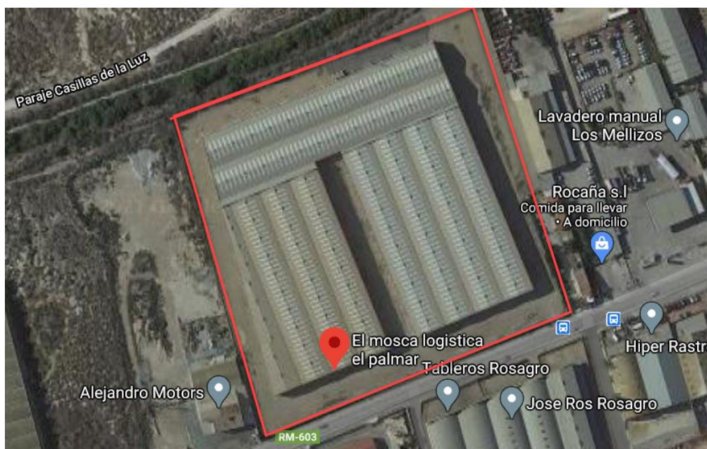
Ilustración 6 Instalación de El Mosca en El Palmar
