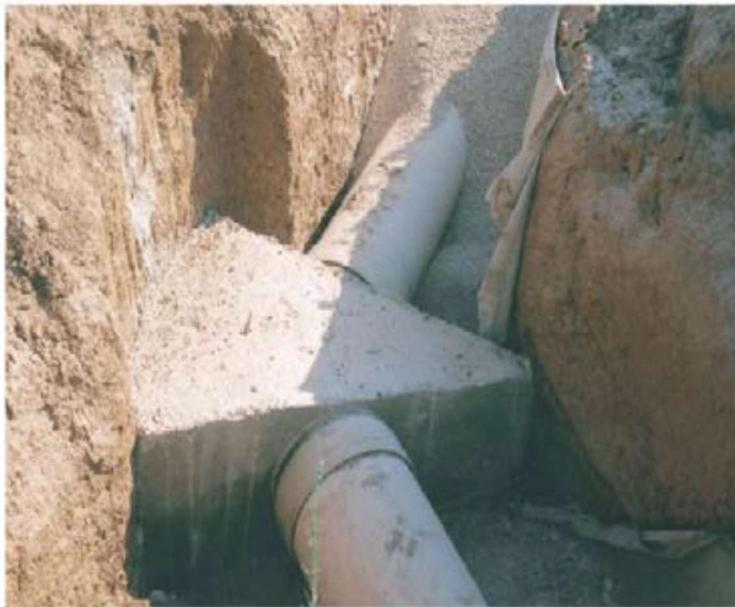
**Ilustración 41. Anclaje en codo (Iagua, 2018)**
