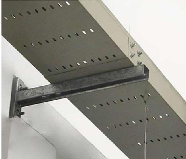
**Ilustración 43. Sujeción de bandejas portacables (auna distribución, 2020)**
