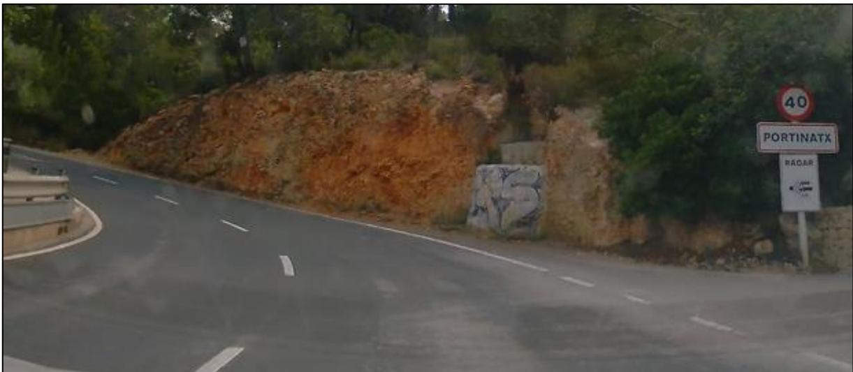
*Figura 85. Señalización S-500 y R-301 40 km/h a la entrada a la población de Portinatx.*
