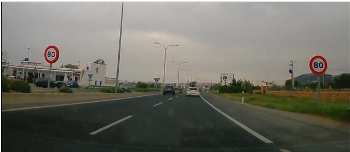
*Figura 150. Señalización R-301 80 km/h previa al paso de peatones ubicado en el PK 12+900 de la carretera EI-600.*
