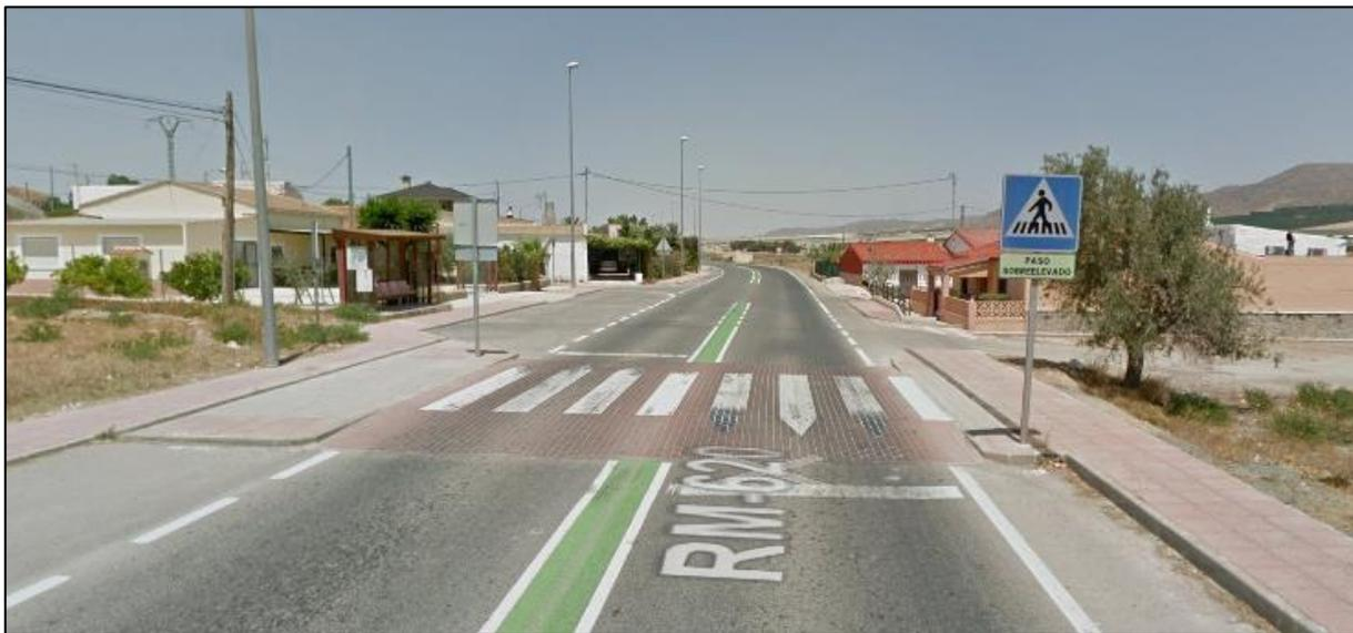
Figura 201. Sección tipo de la carretera RM-620 (Murcia) con paso sobreelevado y separador central pisable, pigmentado y resaltado.
