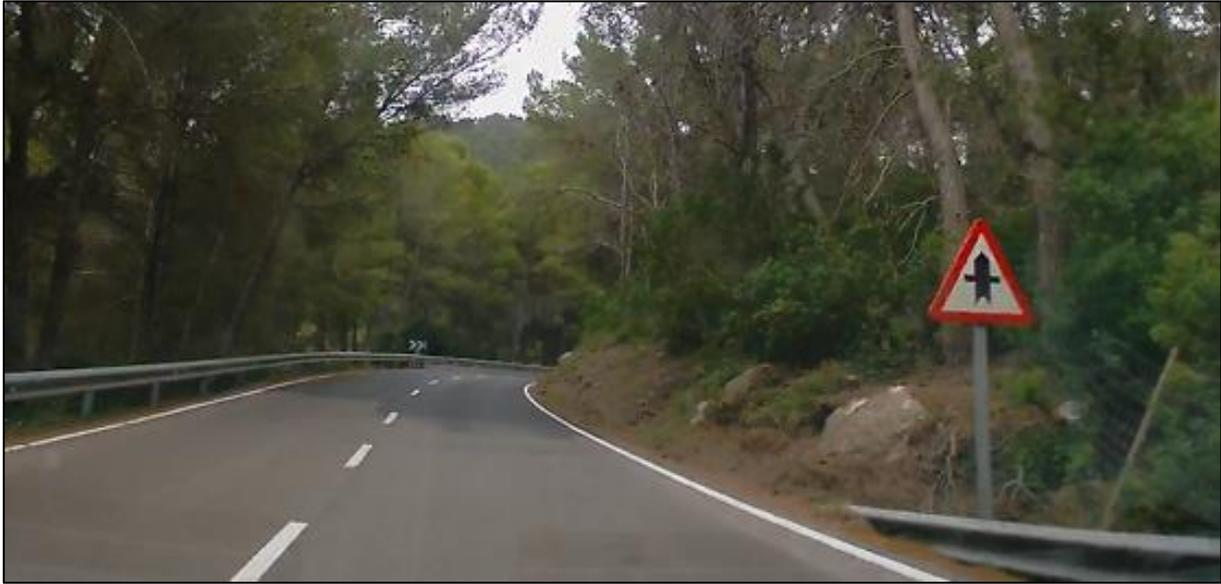
*Figura 134. Curva con visibilidad reducida y línea discontinua como separador central en la carretera EI-541 PK 7+100.*
