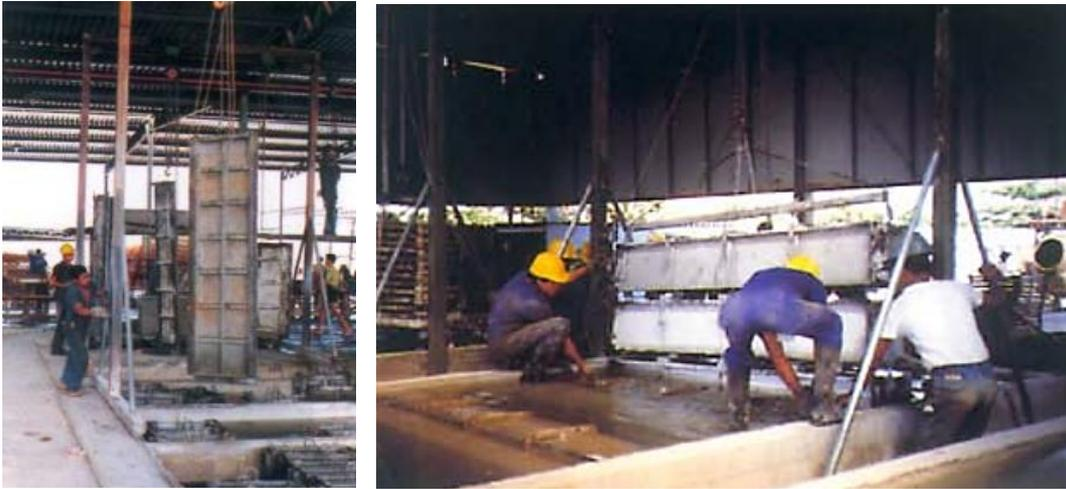
Fig. 78 Curado de las piezas en los tanques de agua
