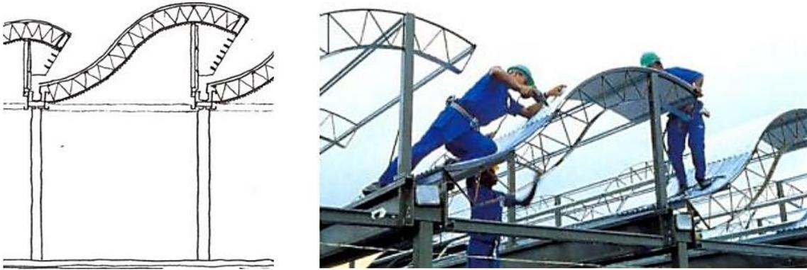
Fig. 60 Esquema y montaje de estructuras de los sheds
