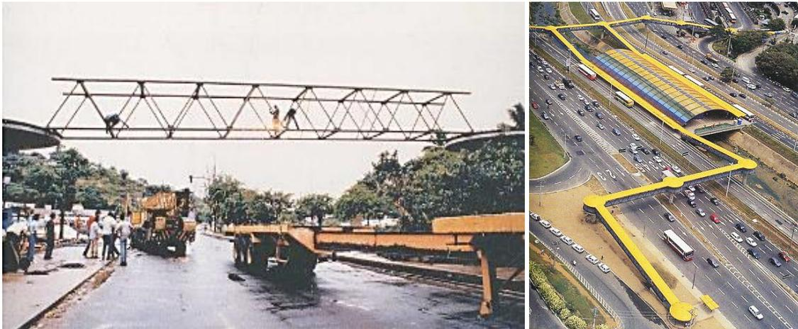
Fig. 87 Prefabricados metálicos para uso de puentes peatonales y estaciones de transporte
