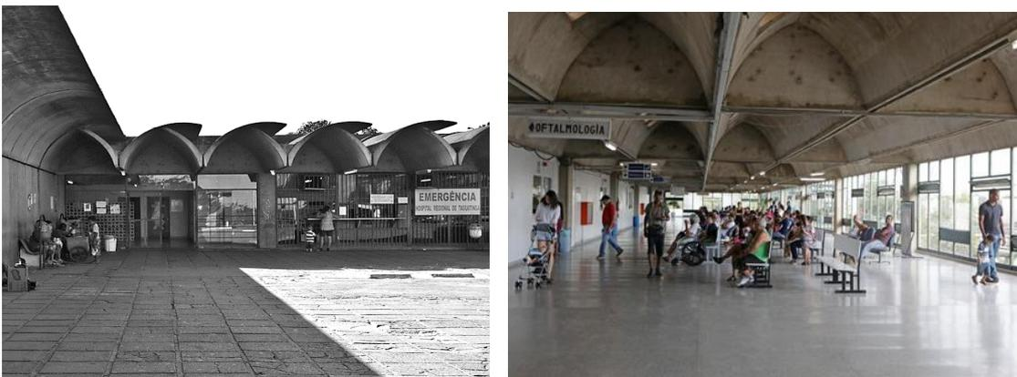
Fig. 30 Detalle de pieza prefabricada de cubierta en exterior e interior
