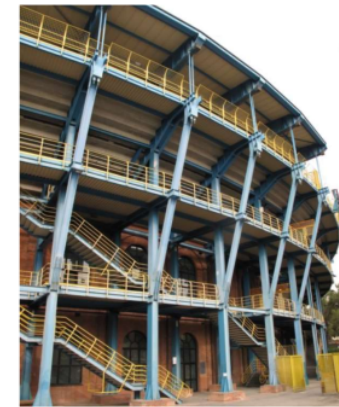
Figura 22. Imagen exterior con la ampliación
