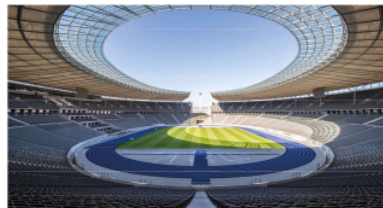
Figura 179. Imagen interior del estadio
