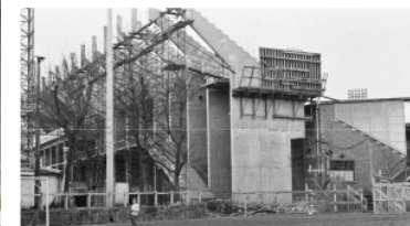
Figura 119. Construcción de la tribuna norte en 1982
