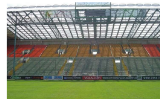
Figura 113. Cubierta sur con plexiglás
