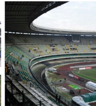
Figura 70. Imagen interior del estadio
