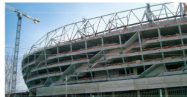
Figura 169. Imagen del proceso de construcción
