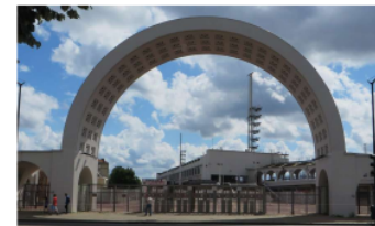
Figura 104. Arco monumental de acceso
