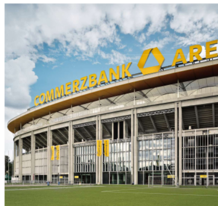
Figura 148. Imágen exterior del estadio
