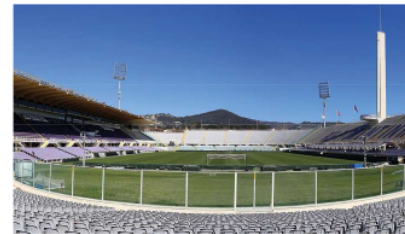
Figura 30. Imagen interior del estadio
