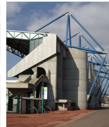
Figura 115. Imágen de la estructura de las nuevas gradas
