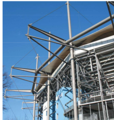
Figura 153. Imagen del exterior con los soportes de la cubierta
