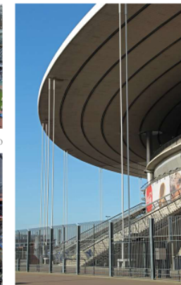
Figura 75. Imagen exterior de los apoyos de la cubierta
