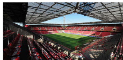
Figura 145. Imagen interior del estadio
