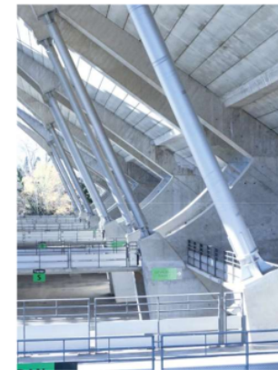
Figura 110. Imagen de la estructura de las nuevas gradas
