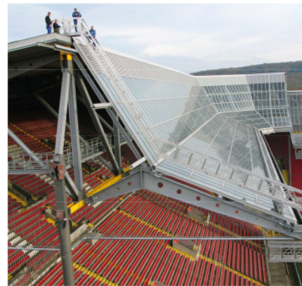
Figura 122. Imagen de la construcción de la cubierta
