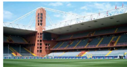
Figura 35. Imagen interior del estadio
