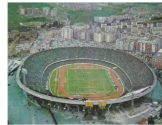
Figura 45. Imagen aérea previa a la reforma
