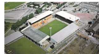
Figura 114. Vista aérea del estadio antes de la remodelación
