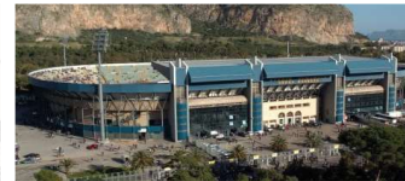
Figura 50. Vista exterior de la fachada principal
