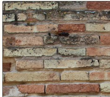
Img. 9.32 Erosión del ladrillo en los paramentos del edificio.
