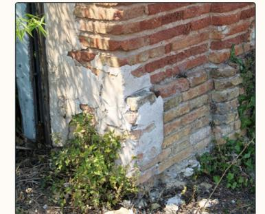
Img. 9.26 Reparación inadecuada del paramento perimetral del edificio.
