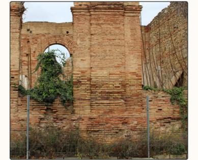
Img. 9.21 Presencia de humedad por capilaridad en la fachada principal.
