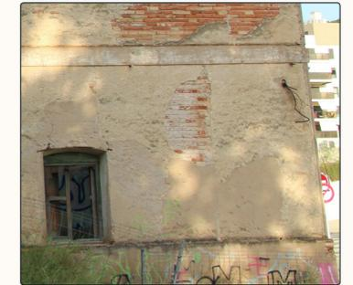
Img. 9.25 Reparación inadecuada en la fachada oeste.
