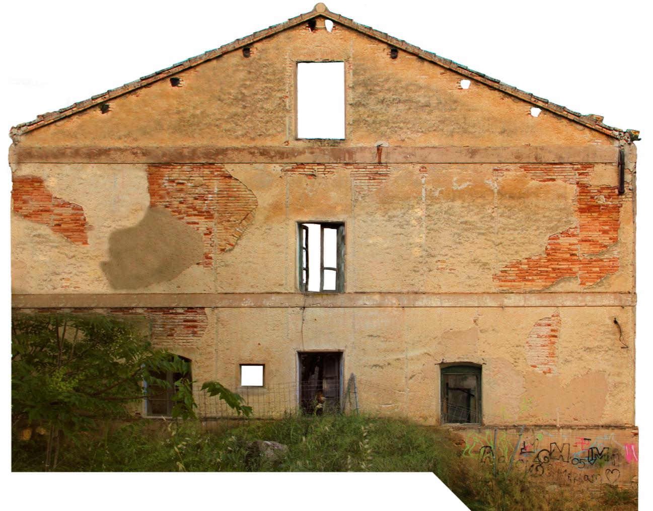
Img. 13.9 Alzado Oeste de la antigua estación de ferrocarril de Xàtiva. E: 1/75. Mediante la aplicación de PhotoScan.
