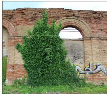
Img. 9.20 Presencia de vegetación en la fachada norte del edificio.
