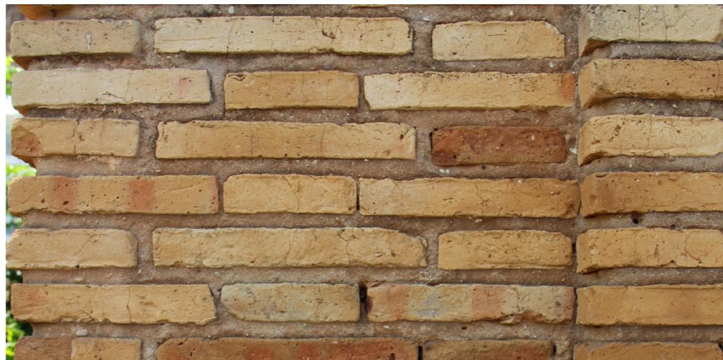
**Img. 6.4** Detalle muro de mampostería con verdugadas de ladrillo. Aparejo flamenco o gótico.
