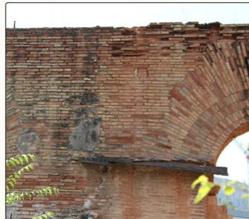
Img. 9.24 Humedad por filtraciones en el paramento interior de la fachada sur.
