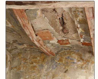
Img. 9.34 Deformación de la viguetta del forjado. Volumen habitacional.
