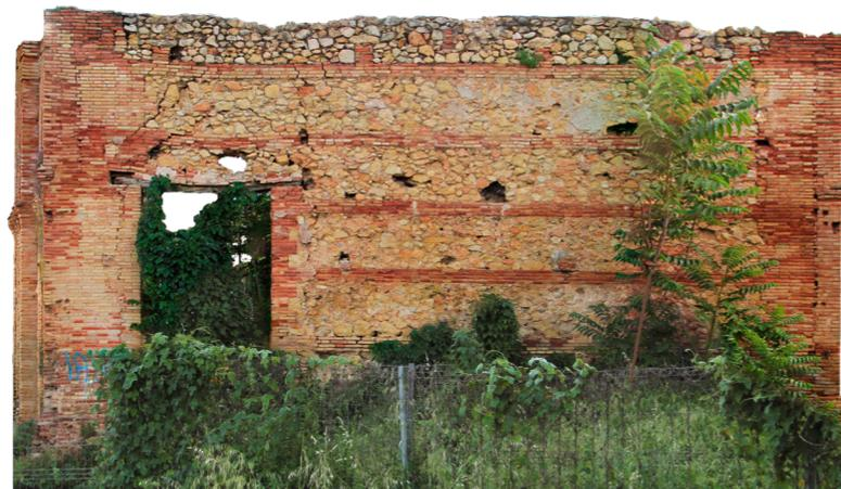
Img. 4.5 Alzado este de la antigua estación de ferrocarril de Xàtiva. E: 1/125. Mediante la aplicación de PhotoScan.
