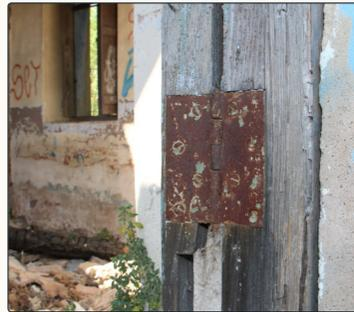
Img. 9.15 Oxidación de las visagras de la carpintería exterior.
