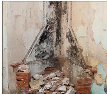
Img. 9.12 Suciedad en los paramentos interiores debido a los restos de la chimenea.
