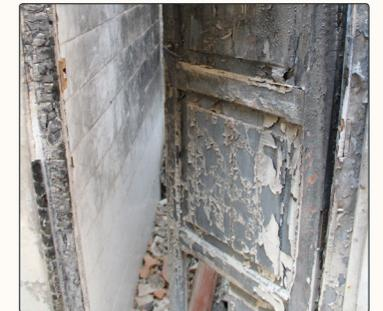
Img. 9.30 Puerta calcinada por incendio en el interior del edificio.
