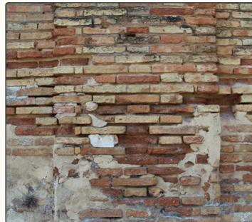
Img. 9.8 Pérdida de material en el muro perimetral del edificio.
