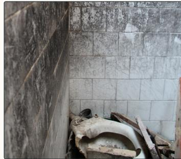
Img. 9.11 Suciedad en los paramentos del baño.
