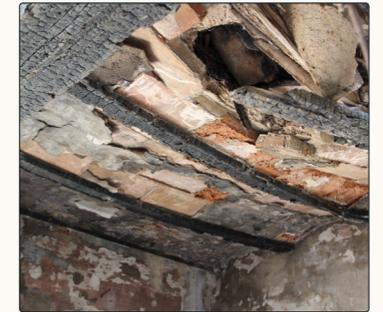
Img. 9.29 Forjado calcinado por incendio en el interior del edificio.
