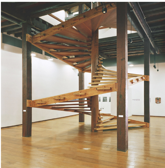
fig. 90: Escalera de madera en espiral, Solar do Unhão.
