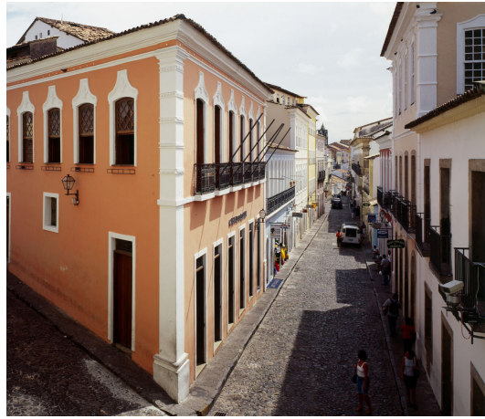
fig. 87: Fachada Casa del Olodum.
