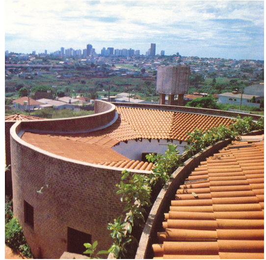
fig. 80: Vista de la cubierta.
