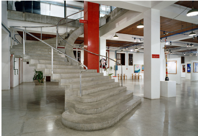
fig. 92: Escalera de hormigón, Teatro Gregório de Mattos
