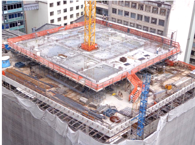
Ilustración 181 - Construcción del tanque de la piscina (Fuente: MMBB Arquitectos).
