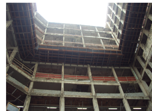
Ilustración 109 - Fotografía desde la planta baja al termino de las demoliciones donde se ve la estructura mantenido. (Fuente: MMBB Arquitectos).
