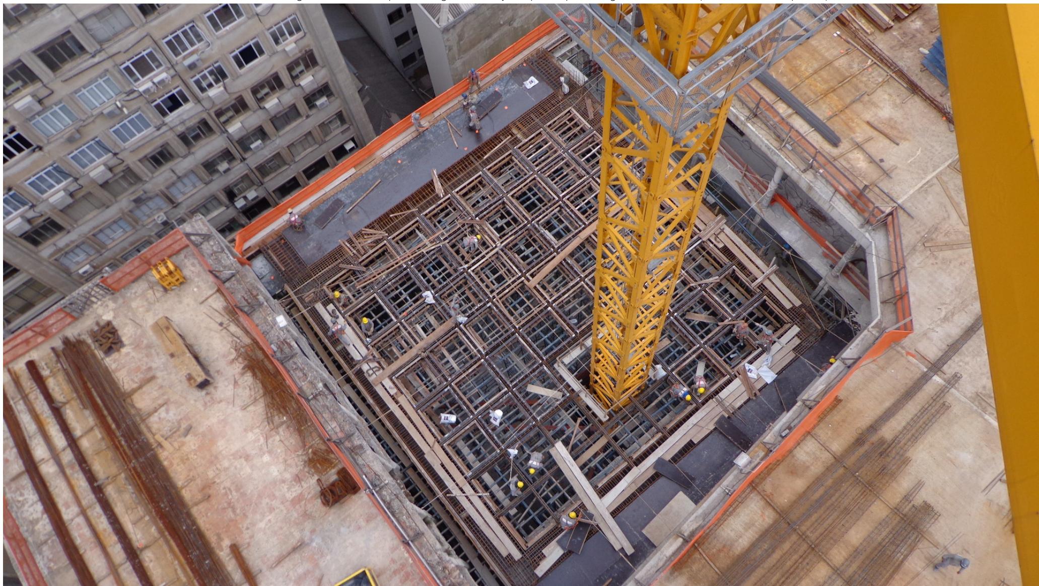
Ilustración 212 - Sesc 24 de Maio en construcción. En el imagen se ve la forma para hormigonar del forjado que ocupa el antiguo vacío central. (Fuente: MMBB Arquitectos).
