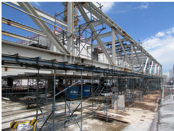
Ilustración 224 - Estructura metálica del bloque de los vestuarios. (Fuente: MMBB Arquitectos).
