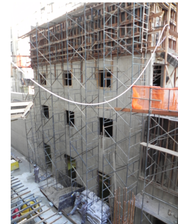
Ilustración 216 - Construcción del edificio anexo en hormigón armado. (Fuente: MMBB Arquitetos).
