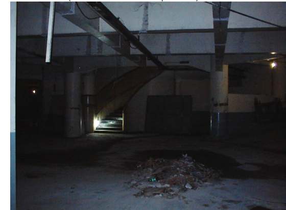
Ilustración 52 - Planta sótano con la escalera de acceso a la tienda. (Fuente: MMBB Arquitectos).
