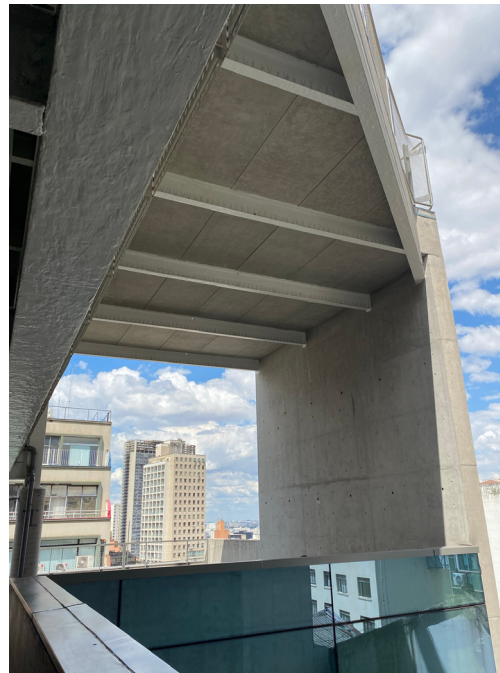
Ilustración 228 - Estructura metálica del solarium engastada en la pared medianera de hormigón armado. (Autoría propia, 2021).
