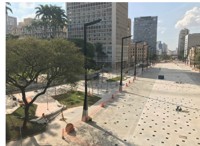
Ilustración 27 - Imagen de las obras del Valle del Anhangabaú de 06/2020. (Fuente: https://avidanocentro.com.br/cidades/vale-do-anhangabau-sera-reformado-veja-como-e-o-projeto/ )
