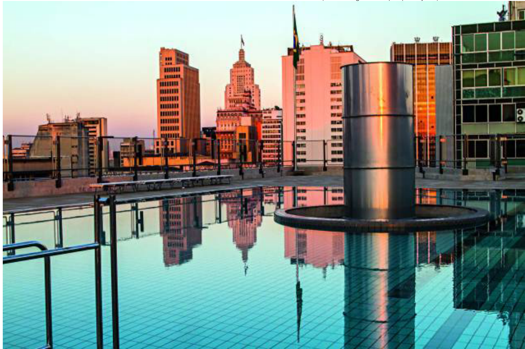
Ilustración 230 - Piscina del Sesc 24 de Maio con el ducto del sistema de extracción de humo en su centro. (Fuente: Rogerio Albuquerque. Veja SP).
