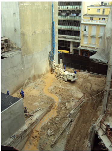
Ilustración 101 - Fotografía demolición del edificio vecino y del acceso original Edificio Mesbla. (Fuente: MMBB Arquitectos).
