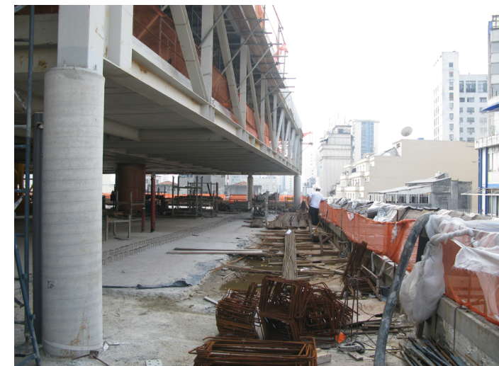
Ilustración 226 - Viga de celosía y sus apoyos en el momento de construcción. (Fuente: MMBB Arquitectos).
