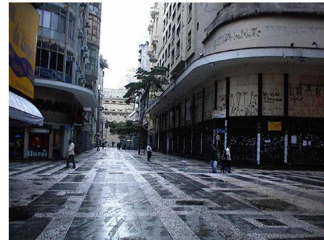
Ilustración 45 - Vista del Edificio Mesbla desde la calle 24 de Maio con el Theatro Municipal de São Paulo al fondo. (Fuente: MMBB Arquitetos).
