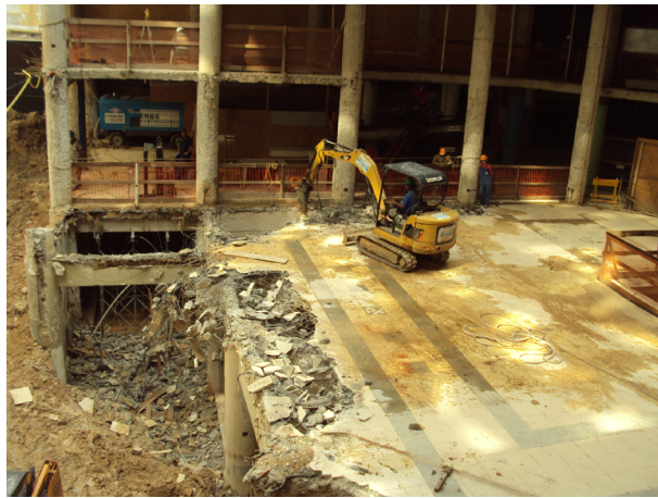
Ilustración 98 - Fotografía de la demolición de la parte central del Edificio Mesbla. (Fuente: MMBB Arquitectos).
