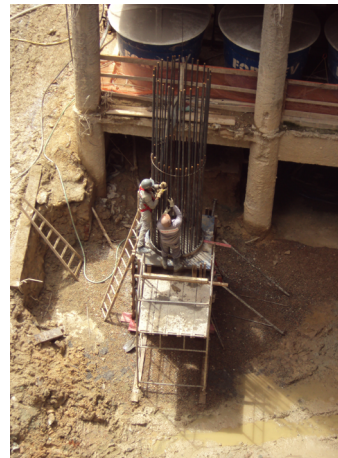
Ilustración 219 - Comienzo de la construcción de los pilares centrales (Fuente: MMBB Arquitetos).
