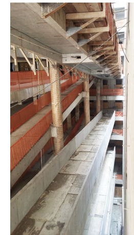
Ilustración 215 - Rampas en construcción. (Fuente: MMBB Arquitetos).
