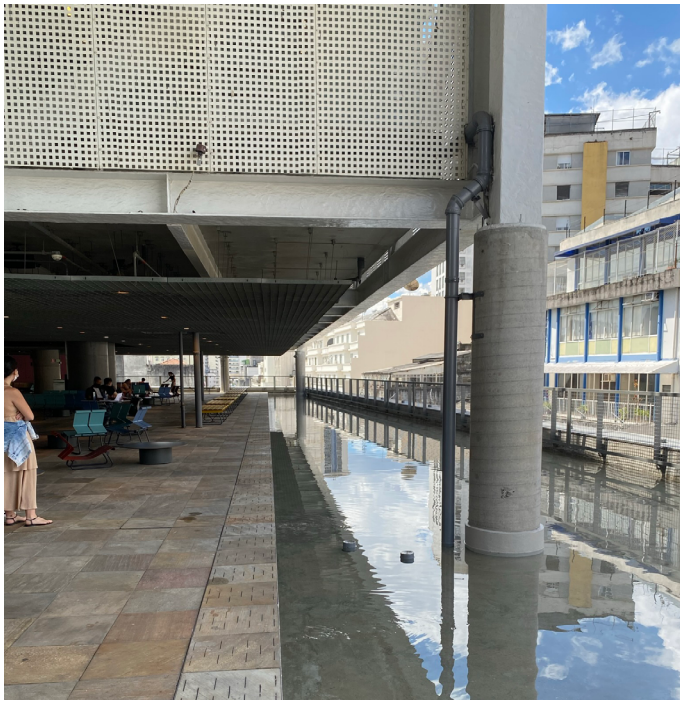
Ilustración 227 - Apoyo de la estructura metálica de los vestuarios en los pilares de hormigón armado. (Autoría propia, 2021).
