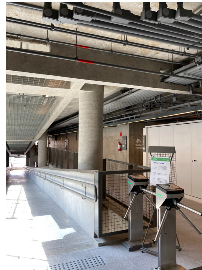
Ilustración 184 - Control de acceso a la zona de los vestuarios de la piscina. (Autoría propia, 2021).
