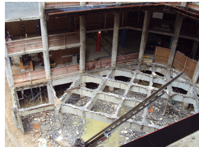
Ilustración 99 - Fotografía demolición del forjado de la planta baja y de los elementos de cerramiento del Edificio Mesbla. (Fuente: MMBB Arquitectos).
