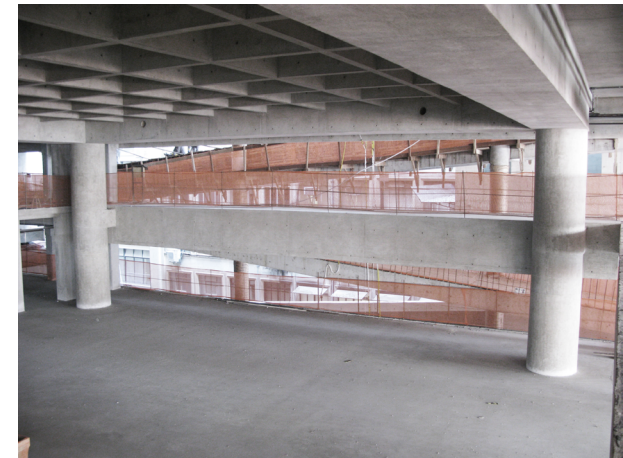
Ilustración 220 - Pilares y forjados con sus luces de 14m y doble altura en el antiguo vacío central. (Fuente: MMBB Arquitetos).
