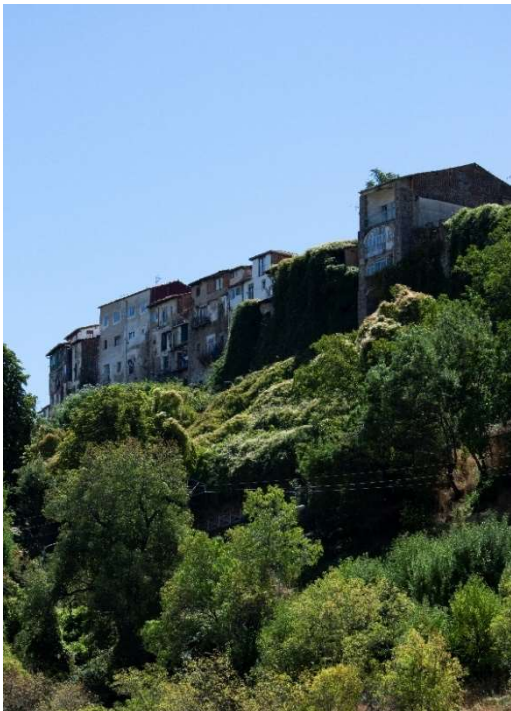
25. Fachada norte de las viviendas de la calle 29 de agosto. Elaboración propia
