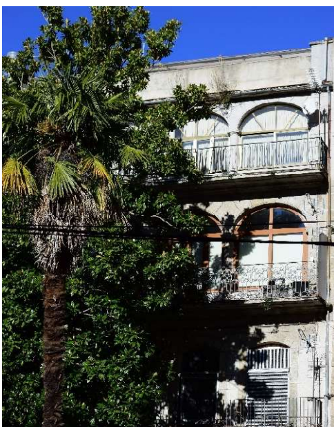
27. Vista de la fachada hacia la Solana (Hoy, Calle Colón). FUENTE: Elaboración propia
