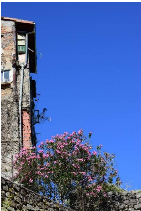
26. Vivienda ubicada en La Antigua. Fachada orientada hacia el valle del río Cuerpo de Hombre. Elaboración propia
