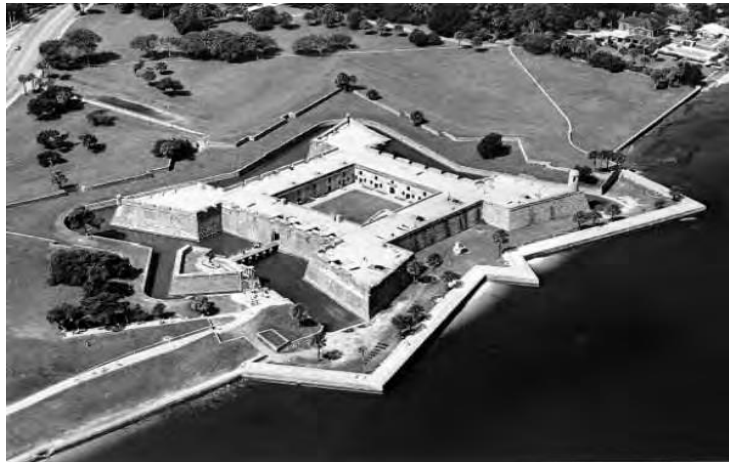
Figura 3: 1672 se empieza a construir el castillo de San Marcos. Fuente: Patricia Davenport and Paul Weaver (2016). St. Augustine National Register Historic District Survey Report For the City of St. Augustine. Pág 4-8.
