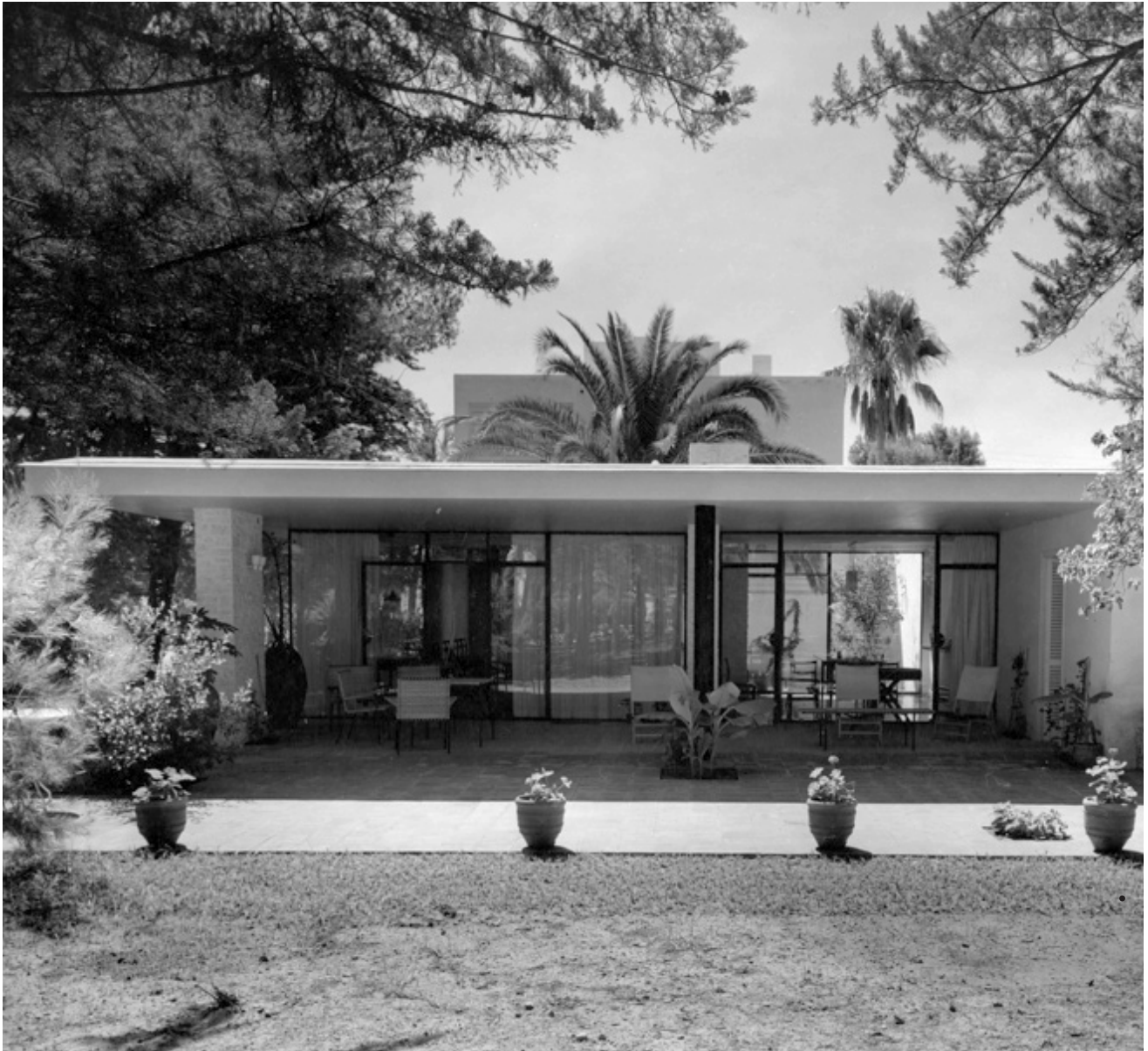
fig. 41 Vista hacia el porche-terrazza principal (3).
