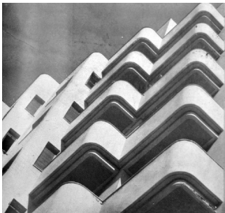
Fig. 14: El edificio Coliseum en construcción.
