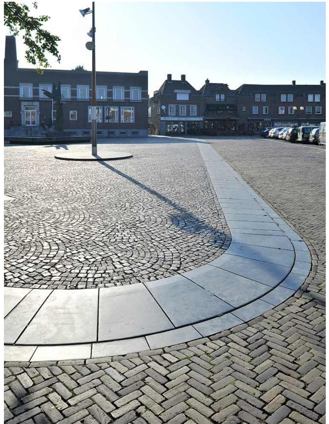
Fig. 44. Plaza repavimentada con ladrillos reciclados.
