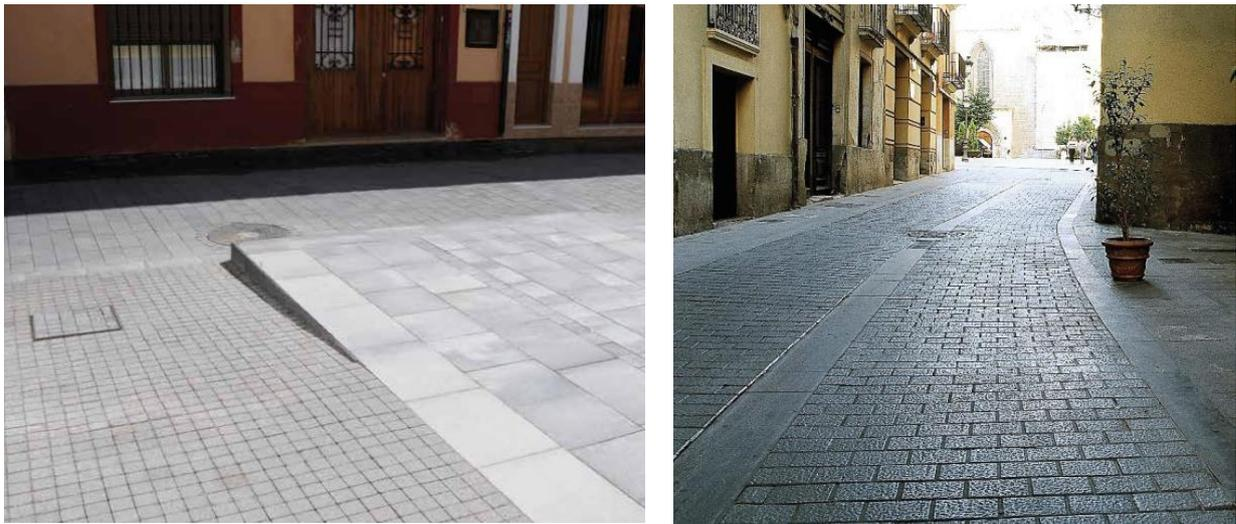
Fig. 41 Ejemplos de pavimentado con diferentes piezas prefabricadas de hormigón.
