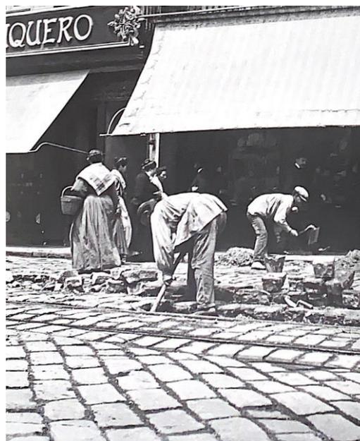
Fig. 58 Trabajos de mantenimiento del adoquinado en la plaza de la Reina, ca. 1920.
