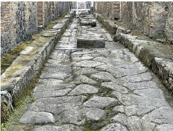
Fig. 8 Pavimento de losas poligonales en Pompeya.
