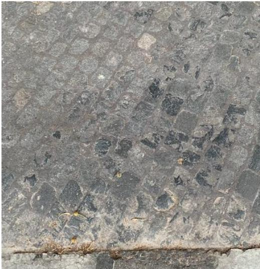
Fig. 70 Adoquinado de pórfido en la zona del Parterre.
