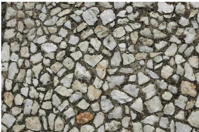
Fig. 108 Detalle del pavimento con junta rellena de áridos.
