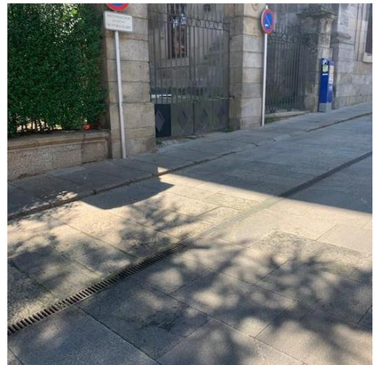
Fig. 89 Ejemplos del enlosado en Santiago. Desagüe puntual y lineal.
