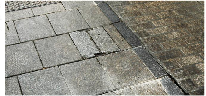
Fractura en la unión con la tapa de registro.
