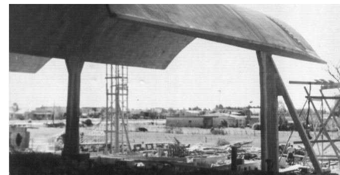
Fig. 63. | Vista a pilares tipo 1 y 3 en la fase 3. Fuente: FADU
