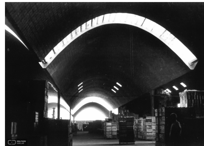
Fig. 39. | Vista lucernario. Fuente: Facultad de Arquitectura de Uruguay
