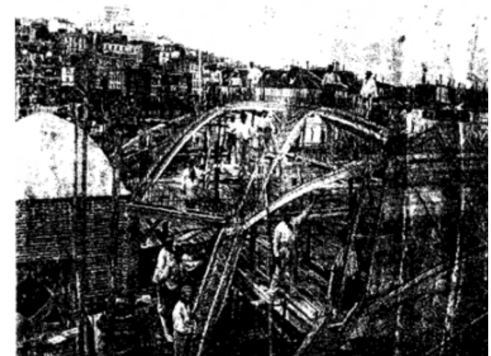
Fig. 5. | Construcción de la Iglesia de Saint Jean de Montmartre. Fuente: Universidad de Sevilla
