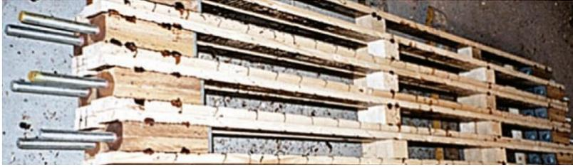
Figura 11. Ejecución de las barras huecas de 3465 mm de longitud.
