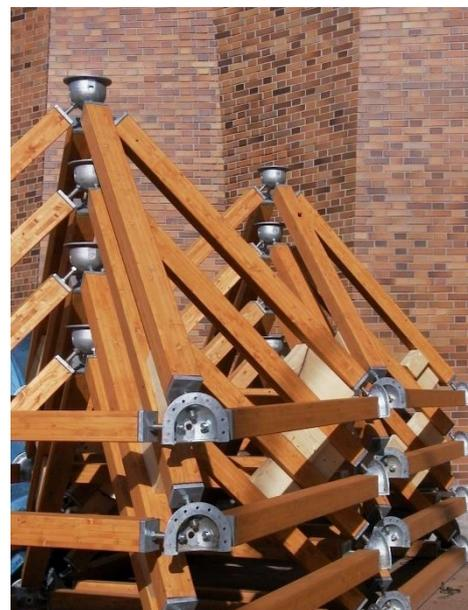
Figura 14. Módulos apilados esperando a ser colocado en la estructura.
