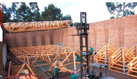
*Figura 22. El primer sector ya está colocado, el segundo se está acabando de ensamblar.*
