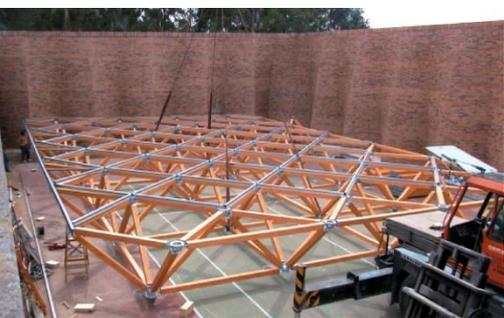
*Figura 20. Ensamblaje de todo el primer sector.*
