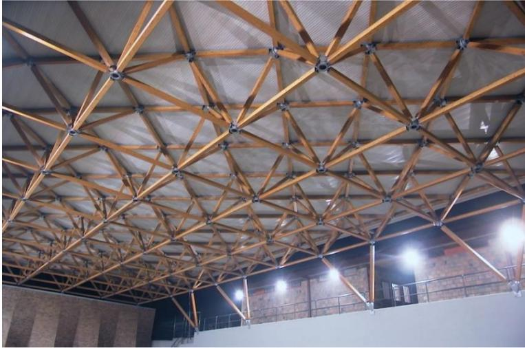
La estructura se soporta a través de sus 4 lados principales, 3 de ellos descansan sobre los muros de fábrica y el otro (uno de los lados de mayor dimensión) descansa sobre 4 soportes en forma de V formados por puntales de barras de madera de sección hueca con dimensiones 150 mm x 150 mm y 30 mm de espesor, unidos directamente al muro de contención del terreno.
