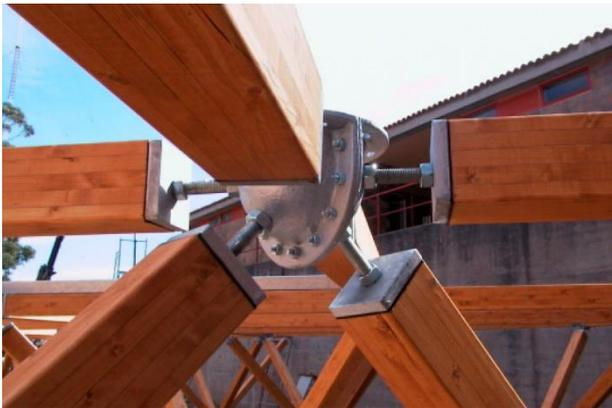
Figura 18. Detalle de un nudo del cordón superior.
