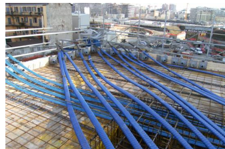
Fig. 07. Fotografía detalle de vainas en el forjado durante la obra
