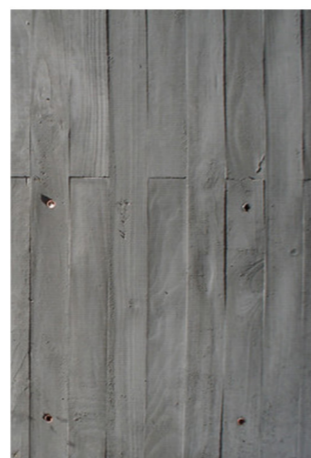
Muro de hormigón visto
