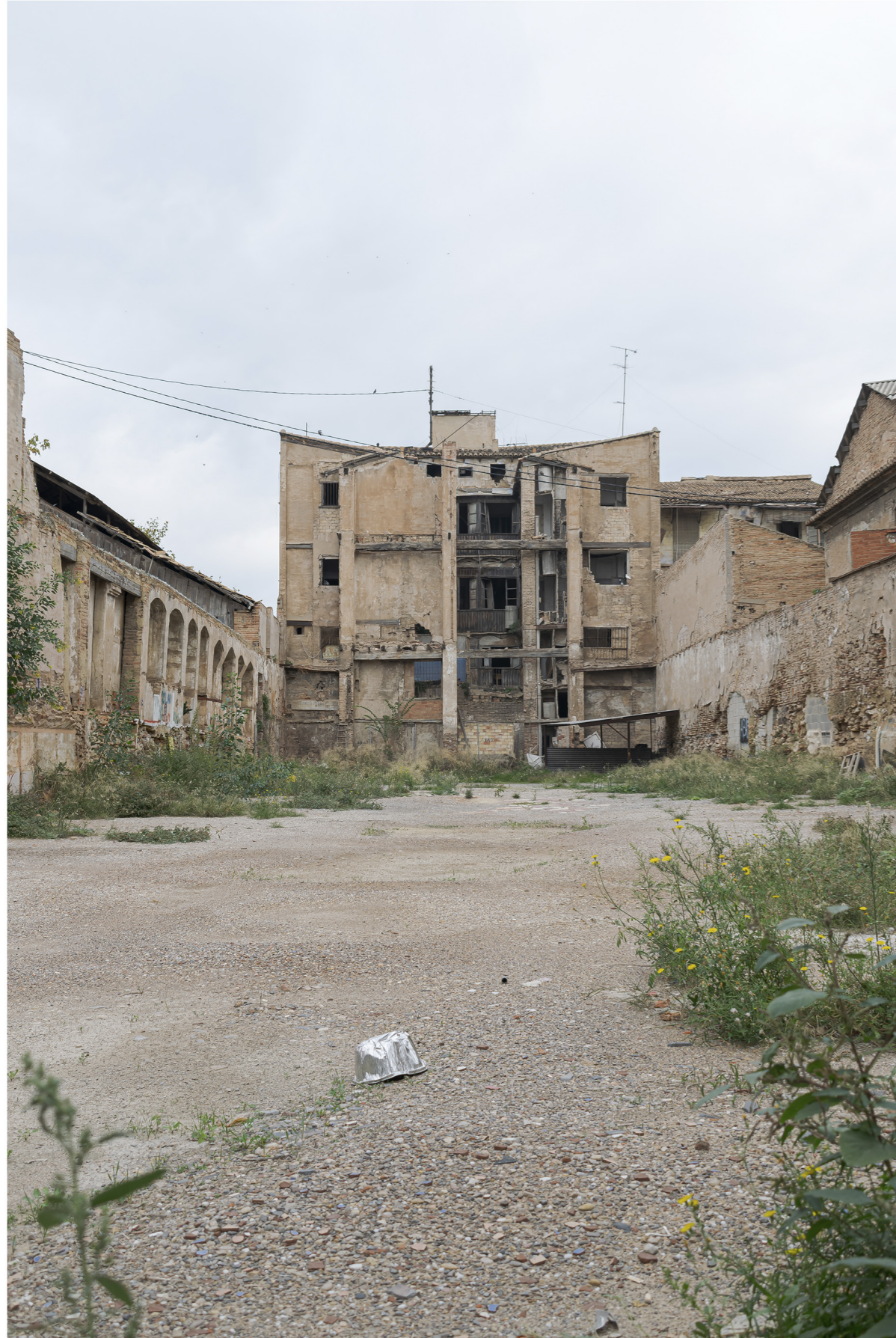
Medianera y preexistencias
