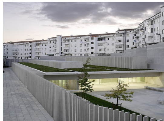
Guardería en Pamplona Arq. Pereda Pérez
