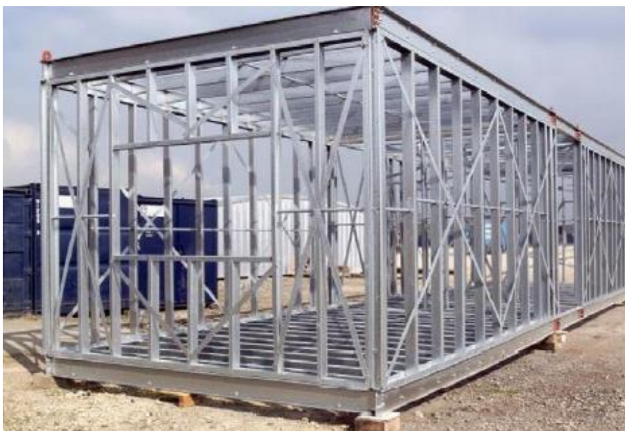
Figura 2.2: Sistema de pilares portantes (4)
