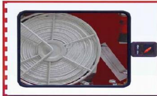
Figura 15. Bocas de incendio [1]
