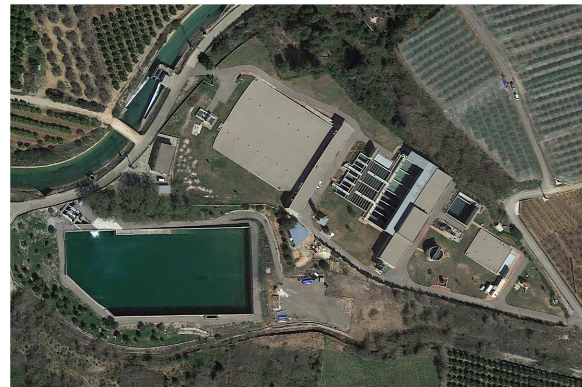
Figura 1: Situación ETAP la Ribera. (Fuente: Google Earth)
