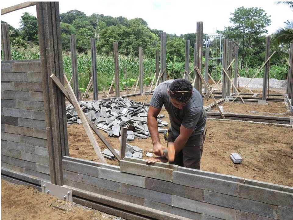
Ilustración 60. Montaje de vivienda con el sistema Bricks & Blocks
