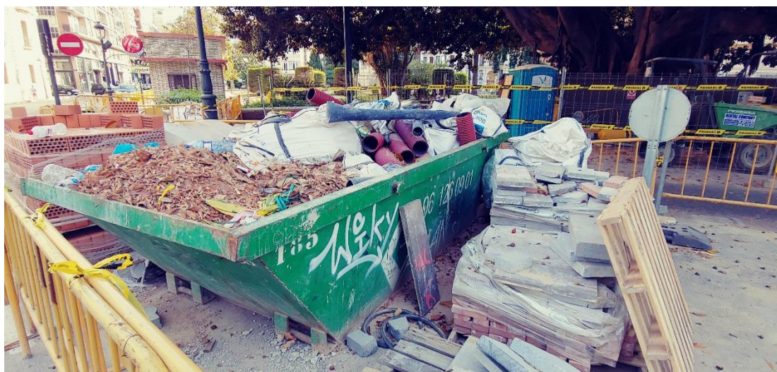
Ilustración 13. Contenedores con residuos plásticos. Valencia.
