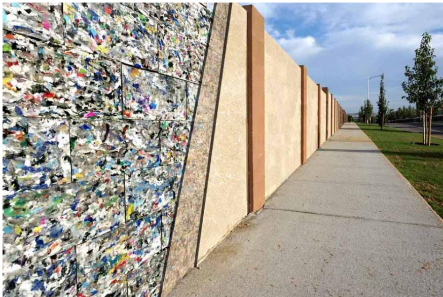
Ilustración 59. Pared fabricada con ByBlock
