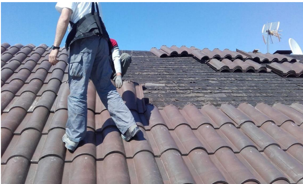
Ilustración 65. Montaje tejas de plástico Roofeco
