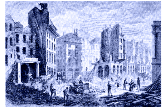
Fig. 4.6 Derribo de edificios en la calle de la Barillerie, para permitir la apertura del Bulevar de Sébastopol en 1859. (Sutcliffe, 1973)
