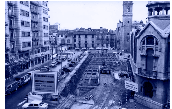
Fig 7.22 Construcción del estacionamiento subterráneo del Mercado Central. Autor desconocido, ca. 1969. Fuente: (Mifsut, 2016)
