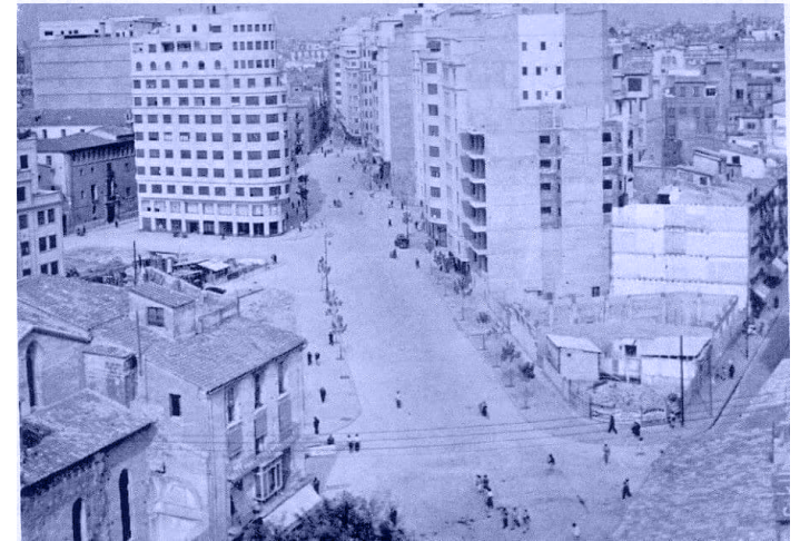
Fig 7.21 Avance en la construcción de la Avenida del Oeste. Autor desconocido, Ca. 1948. Fuente: José Montalar
