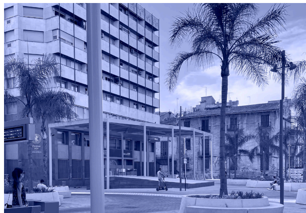
Fig 8.1 Fotografía actual del encuentro de las construcciones modernas con la arquitectura vernácula del entorno. Archivo personal.
