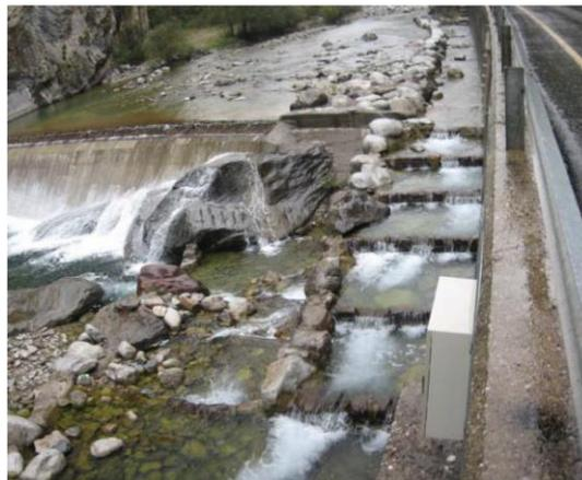
Fig. 51. Escala de artesas. Río Cinca (Huesca). Fuente: Protocolo de permeabilización de obstáculos en la cuenca del Ebro (2009)
