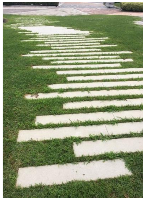
PAVIMENTO FILTRANTE Zona Verde
