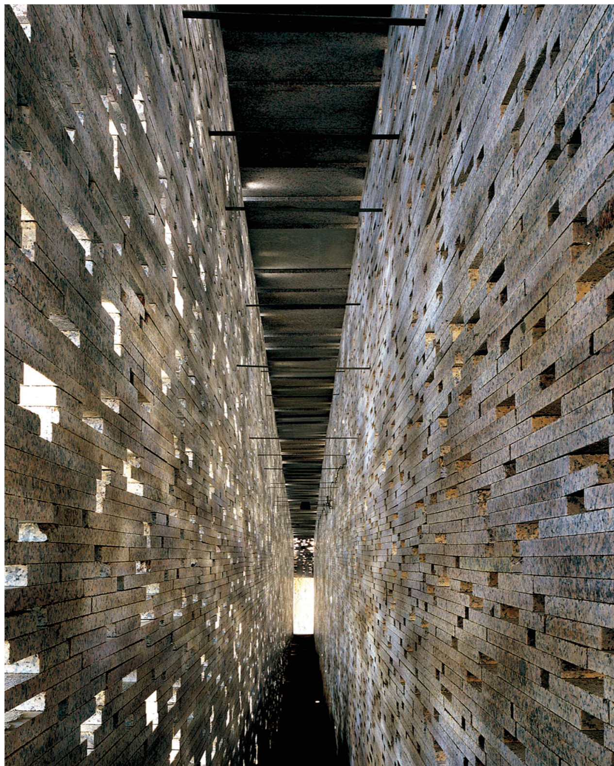
Vista interior de la Muralla Nazarí en el Alto Albacín. Proyecto de Antonio Jiménez Torrecillas
