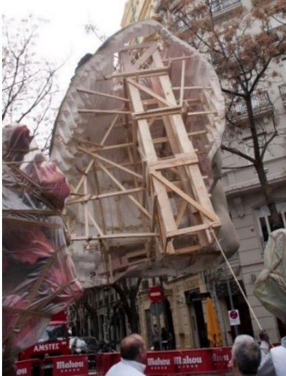
Fig. 35 de una de las torres antes de encajarla en el caballete.
