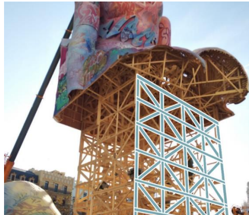
Fig. 56 Dibujo explicativo de una torre central de madera.
