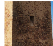
Figura 18. Troneras de la Torre del Mar, Borriana.
