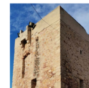
Figura 21. Corsé de hormigón en el remate de la Torre de La Mar, Borriana.
