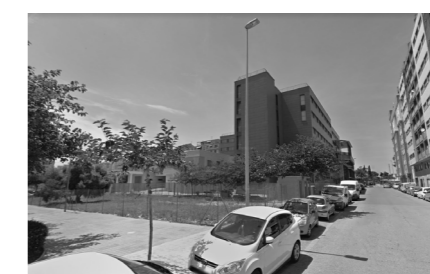
Figura 1.13: Centro de Salud Gran Vía.
