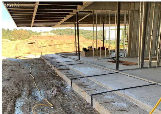
IMG17 - Ejecución Detalle
