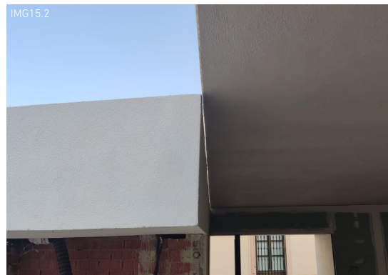
IMG15 - Detalle Ejecutado
