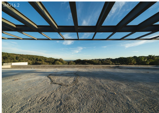
IMG16 - Ejecución Plano de Cubierta
