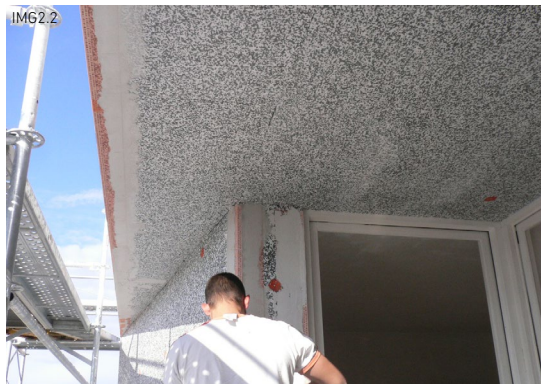
IMG2 - Ejecución Fachada SATE
