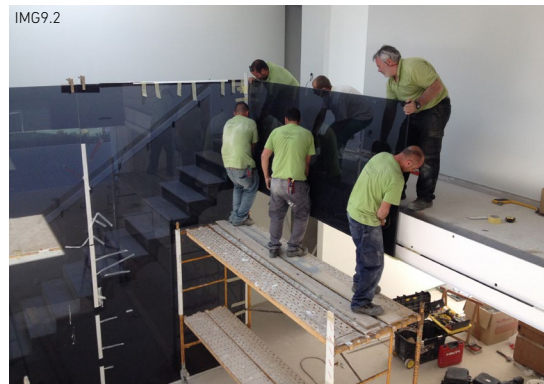
IMG9 - Colocación Vidrio Ahumado
