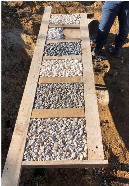
IMG12 - Gravas Cubierta
