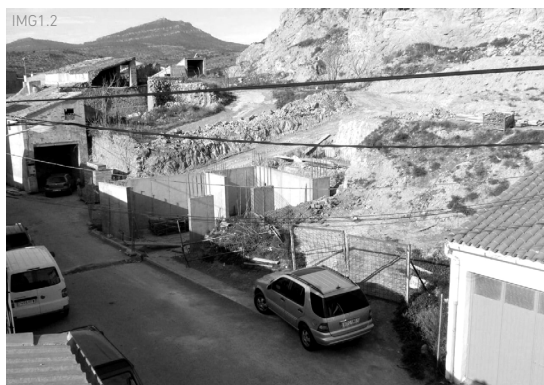
IMG1 - Ejecución Estructura
