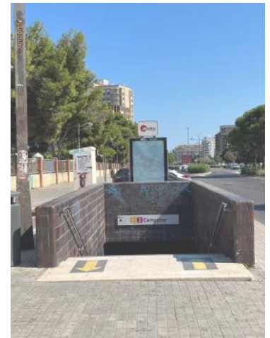
Figura 159. Parada de metro en la Avenida de las Cortes Valencianas
