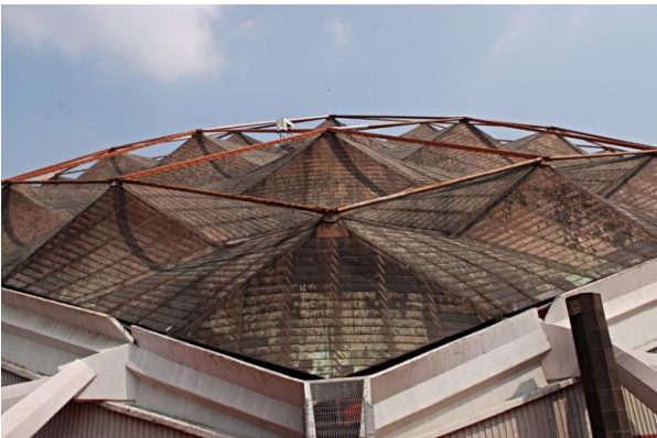
Img. 4 Encuentro membrana con contrafuertes.
