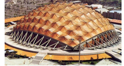
Ilustración 7: Palacio de los Deportes. Fuente: Plataforma arquitectura.
