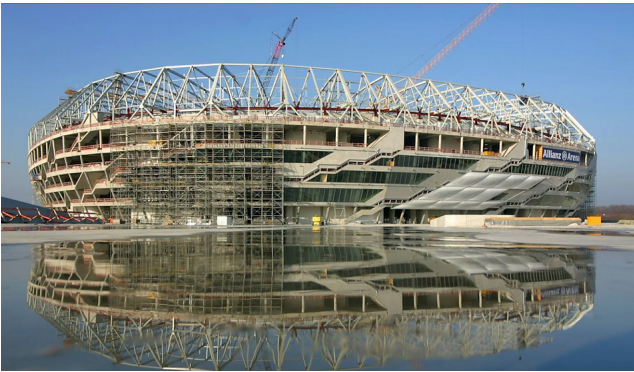
Img. 21 Proceso de construcción fachada. Allianz Arena.
