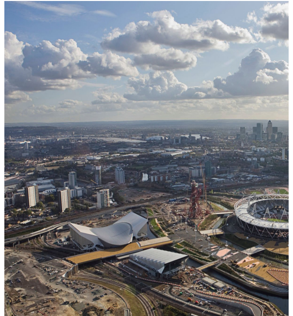
Ilustración 23: Vista aérea del Centro acuático. Fuente: Gettyimages.
