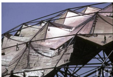
Ilustración 29: Cubierta formada por paraboloides hiperbólicos de aluminio tubular sujetos a los arcos de acero. Fuente: Plataforma arquitectura.
