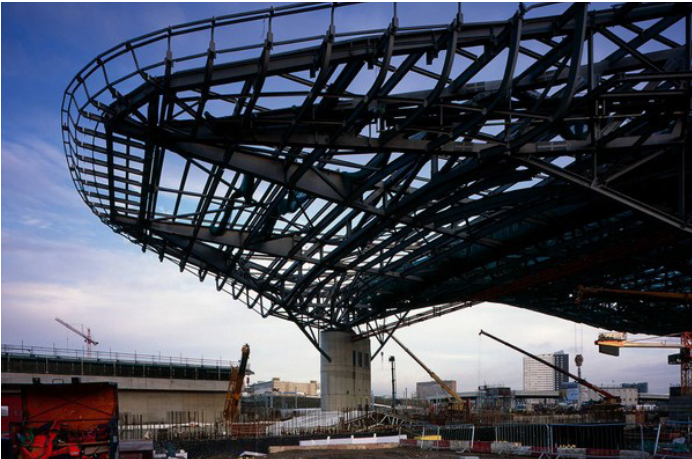
Img. 26 Proceso de construcción. Centro Acuático Londres 2012.
