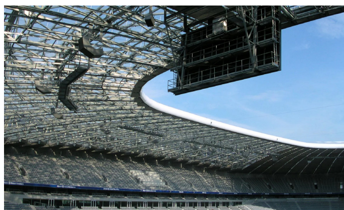
Ilustración 40: Estructura metálica de la cubierta del estadio. Fuente: WikiArquitectura.
