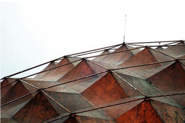
Img. 3 Detalle membrana 2. Palacio de los Deportes.
