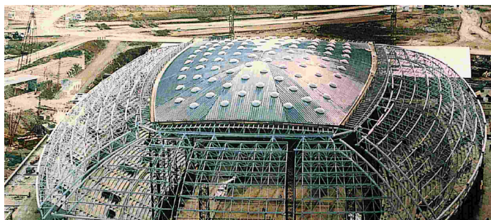
Ilustración 45: Acabado de zinc de la cúpula. Fuente: Asociación de Ingenieros de Caminos, Canales y Puertos y de la Ingeniería Civil.
