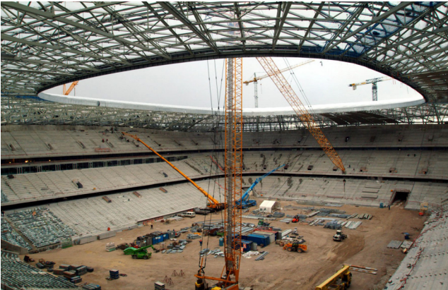
Img. 20 Proceso de construcción. Allianz Arena.
