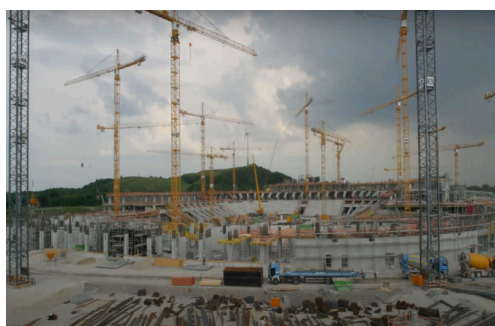
Ilustración 50: Construcción de la estructura de hormigón. Fuente: time lapse | panTerra.
