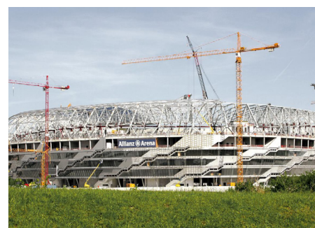
Ilustración 52: Construcción estructura de acero. Fuente: Christiane Gabler. Arquitectura Viva.
