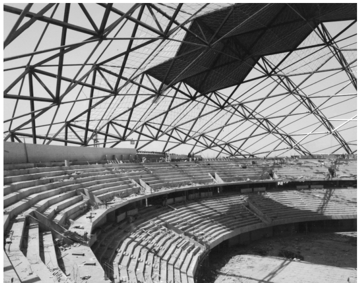
Img. 6 Construcción estructura de la cubierta.
