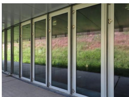
Ilustración 48: Carpinterías metálicas del perímetro. Fuente: WikiArquitectura.
