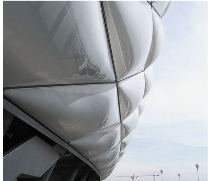
Img. 24 Fotografía exterior. Allianz Arena.
