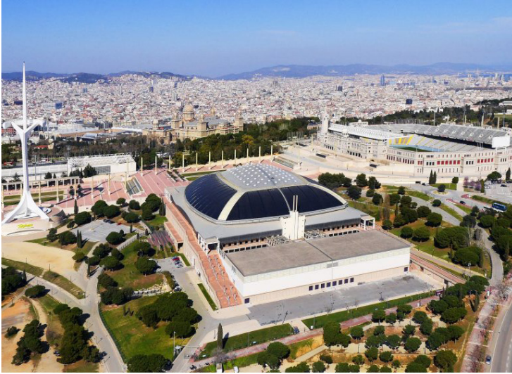
Ilustración 14: Vista aérea del Palau Sant Jordi. Fuente: Ajuntament de Barcelona.
