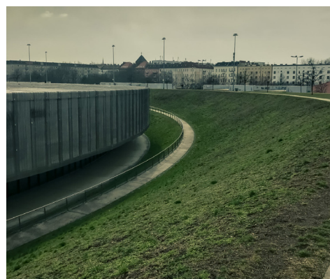
Ilustración 38: Exterior con el recubrimiento de la malla metálica. Fuente: Revista The Arup Journal .
