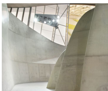
Ilustración 42: Muro de HA donde apoya la cubierta. Fuente: IS Arquitectura.
