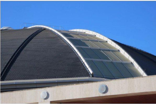
Img. 8 Detalle cubierta exterior. Palau Sant Jordi.
