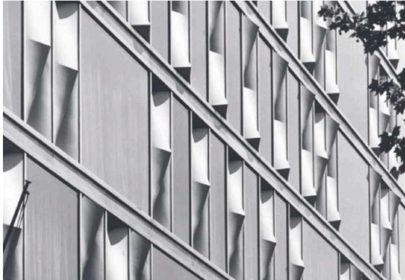
Fig. 25. Paneles en forma de paraboloides que Fargas y Tous utilizan en la fachada de Banca Catalana, en una arquitectura con mensaje. *Forma y construcción en Arquitectura*, nº8, p. 157. Universidad de Sevilla.
