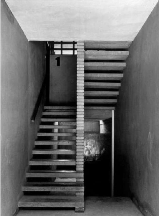
Fig. 64. Las escaleras que comunican las distintas viviendas son un ejemplo de austeridad constructiva. Fotografía de Maspons.
