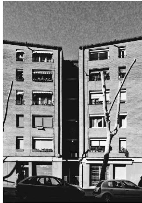
Figs. 59 y 60. El retranqueo de la fachada rompe con el modelo tipo de bloques de vivienda masiva. Fotografía de Jaume Prat. Arxiu MBM.
