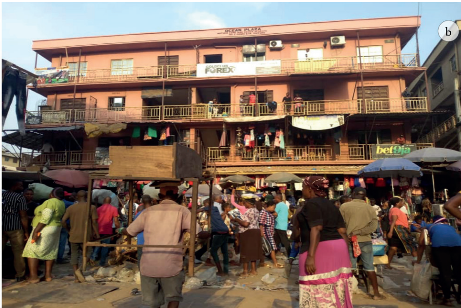
Figura 6. Dalt: Carrer d'accés dins de Bridgehead-Market, mostrant apropiacions efímeres als carrers per al comerç, emmagatzematge i plataformes de càrrega/descàrrega. Baix: Definicions de propietats difuminades (carrers i places) dins de Main-Market. Darrere d'aquest aparent desorganitzat, hi ha un mecanisme de clúster organitzat que dona un sentit de lloc i la socialitat que l'acompanya que defineix les relacions de poder en els mercats.
