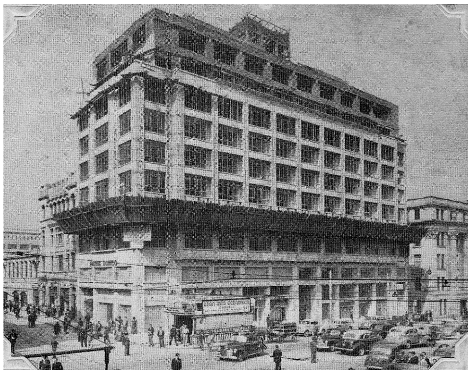
Figura 4.8 Edificio Faux en 1947 En proceso de construcción. Aunque ya habían construcciones que delineaban el nuevo paramento de la Carrera Séptima no fue sino hasta que se emplazó este edificio que el paramento quedó claramente definido.
