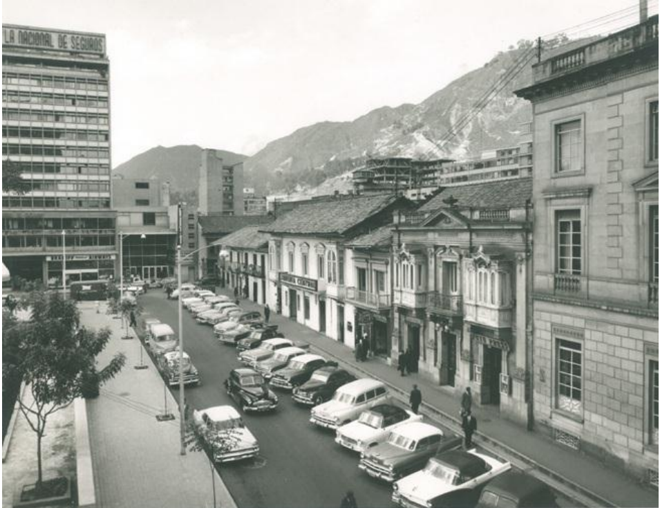
Figura 4.35 Costado oriental del Parque Santander hacia 1961 cuando ya se había remodelado y aún conservaba áreas de circulación vehicular.
