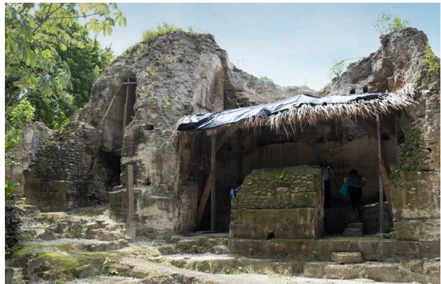
Figura 5.49. Cubierta provisional del cuarto de los grafitos. Fotografía R. Martínez Vanaclocha (2022).
