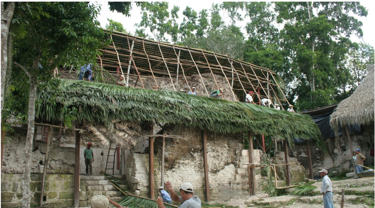
Figura 5.33. Instalación de cubiertas vegetales en el palacio de Oriente. Fuente: Archivo Proyecto La Blanca (2010).
