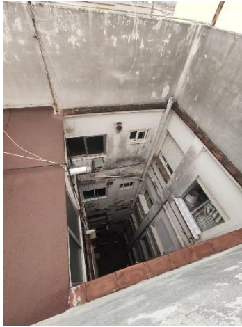
Ilustración 21. Patio interior F5
