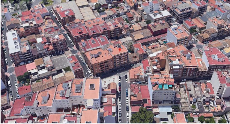
Ilustración 3. Situación del edificio.
