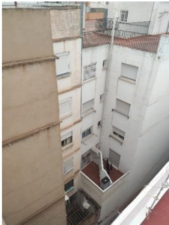
Ilustración 23. Patio interior F4.
