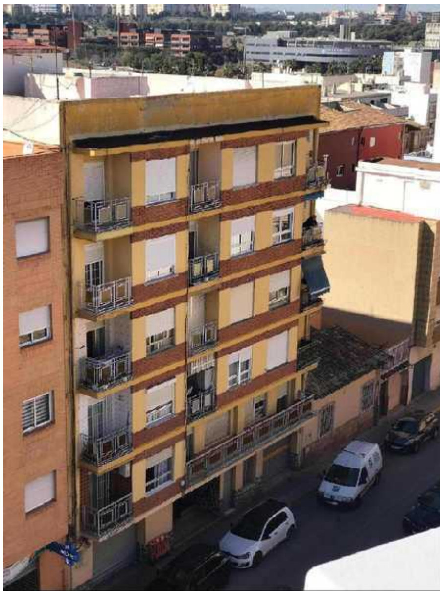
Fotografía de la fachada principal
