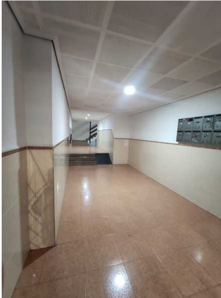
Accesibilidad. Existencia de desnivel [Ref. AC001]
