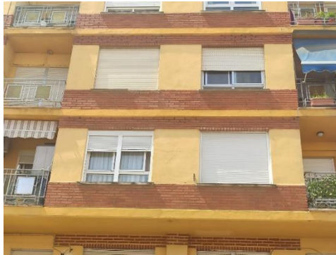
Ilustración 11. Cerramiento de fachada principal.
