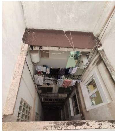
Ilustración 24. Patio interior F6.
