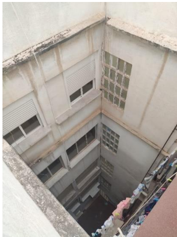
Ilustración 12. Cerramiento de fachada de patio interior.
