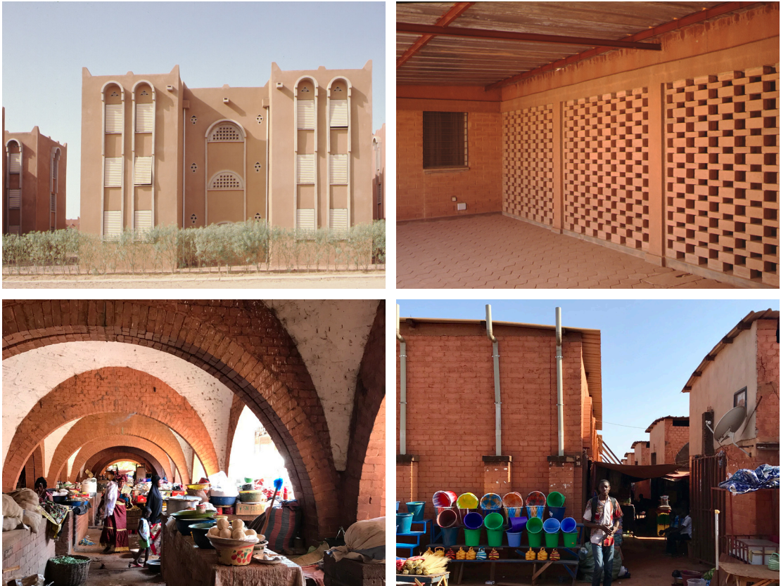
Fig.3.6. Construcciones derivadas de la experiencia LOCOMAT (arriba). Interior y exterior del mercado de Koudougou, diseñado por Laurent Séchaud, y construido con BTCs y sistemas de doble cubierta metálica (abajo). Fuente de las dos imágenes superiores: CRAterre.
