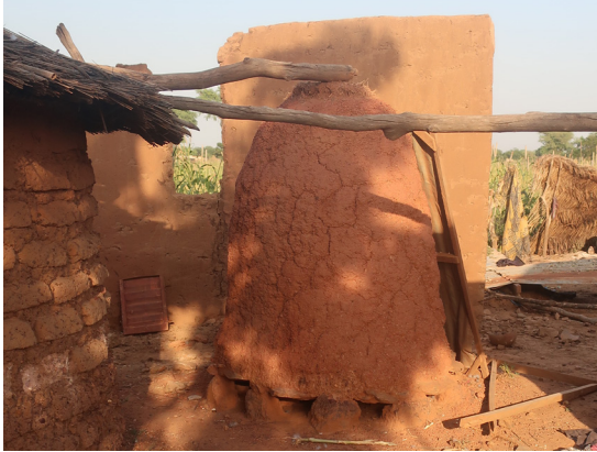
Fig.2.32. Graneros de paredes de banco en un patio en Baasneere. Este tipo de graneros se construían con tierra, a diferencia de los grandes recipientes de paja trenzada situados en los campos, por su tamaño más reducido y para protegerlos de los fuegos en el interior del patio.
