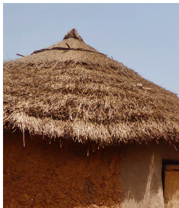
Fig.2.40. Diferentes soluciones de protección frente al viento en la ejecución de las cubiertas en las culturas lobi, gouin y kassena. Fuente: Fernando Vegas y Camilla Mileto.
