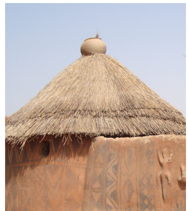
Fig.2.40. Diferentes soluciones de protección frente al viento en la ejecución de las cubiertas en las culturas lobi, gouin y kassena. Fuente: Fernando Vegas y Camilla Mileto.
