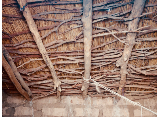
Fig.2.41. Cubierta plana de tierra y paja en el pueblo de Baasneere.
