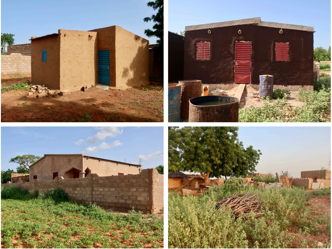
Fig.2.15. Ejemplos de tipologías modernas identificadas en Baasneere: pistolet , con dos estancias formando una "L"; construcción en miroir , con dos estancias; villa , con múltiples habitaciones. La última imagen muestra construcciones rectangulares entrer-coucher en un patio tradicional.
