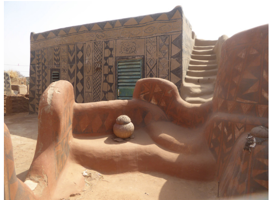
Fig.2.33. Construcciones kassena : muros, escalones, bancos o altares se moldeaban con tierra y parecían un elemento continuo. Fuente de la fotografía: Fernando Vegas y Camilla Mileto.
