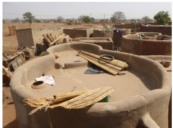
Fig.2.42. Cubiertas planas aterrazadas en la arquitectura lobi en el pueblo de Samsana (arriba); y en la arquitectura kassena en Tiébélé (abajo). En ambos casos, las tinajas se utilizaban para conformar los huecos que permitían la entrada de luz al interior. Fuente: Fernando Vegas y Camilla Mileto.
