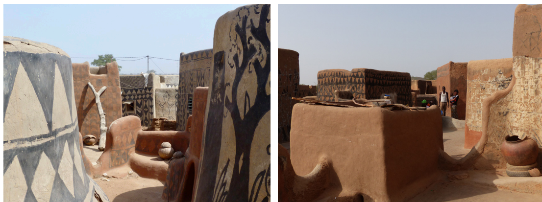
Fig.2.7. Vista desde los patios privados de las unidades residenciales en la Cour Royale de Tiébélé (izquierda) y en Tangassoko (derecha). Fuente: Fernando Vegas y Camilla Mileto.
