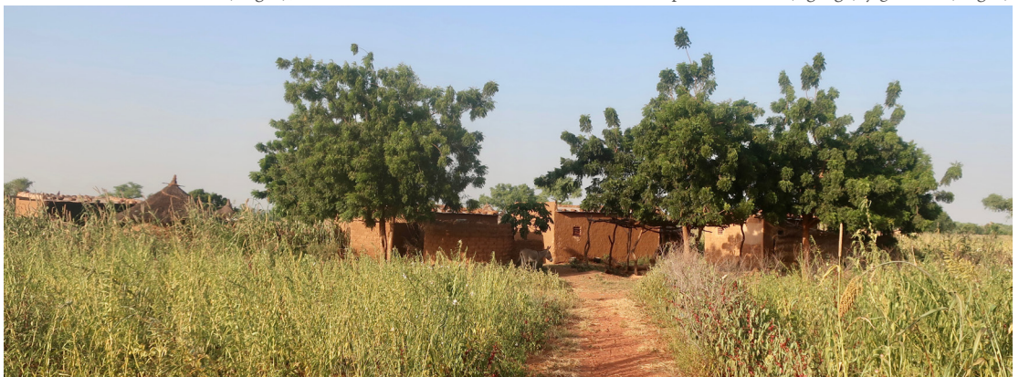
Acceso al patio exterior ( samadé ) y al recinto ( zaka ) por el camino entre los campos de la familia ( kamanga )
