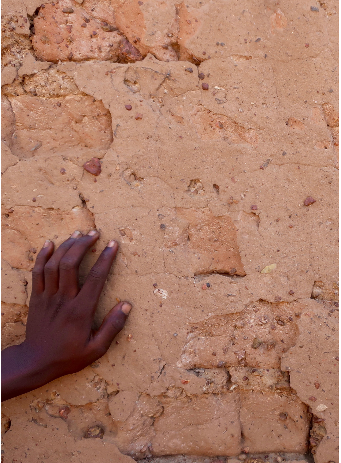
Fig.2.31. Muro de adobe y revestimiento erosionado de tierra en una vivienda en Baasneere, 2018.
