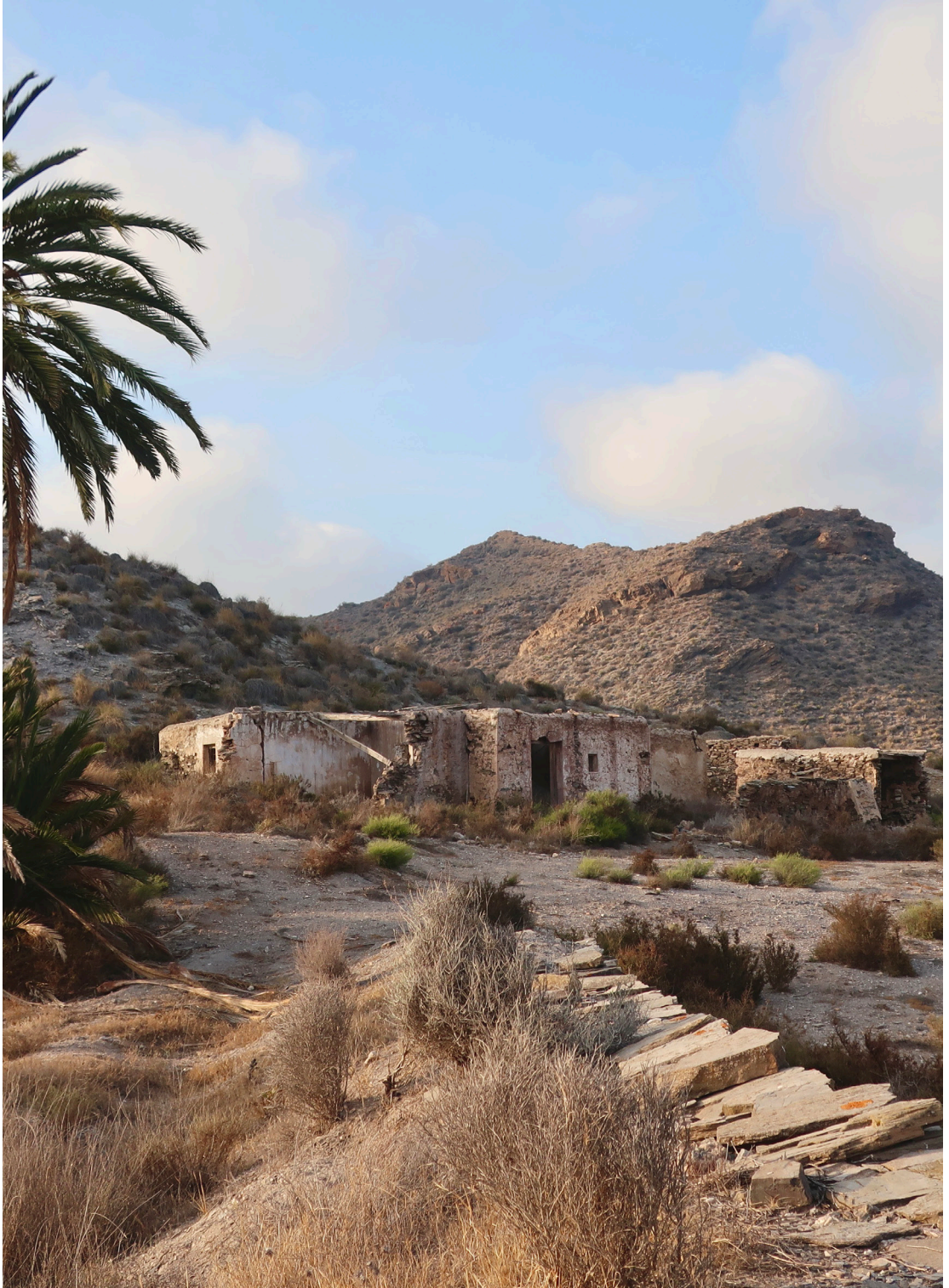
Fig.1.1. Cortijo abandonado en Pilar de Jaravía, Almería (España), 2018.
