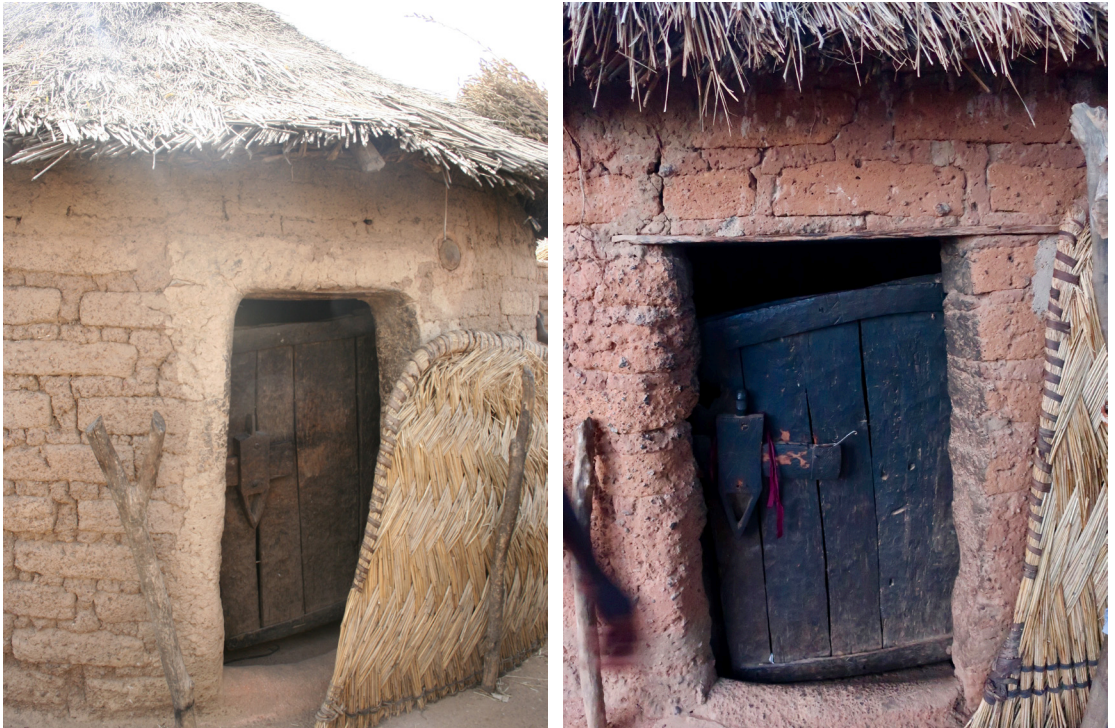
Fig.2.47. Fotografías de una puerta tradicional mantenida en 2011 (izquierda) y 2018 (derecha), con los dos sistemas, puerta de madera y estera de séko , además de cerradura. Fuente de la primera imagen: Xavi Ferragud.
