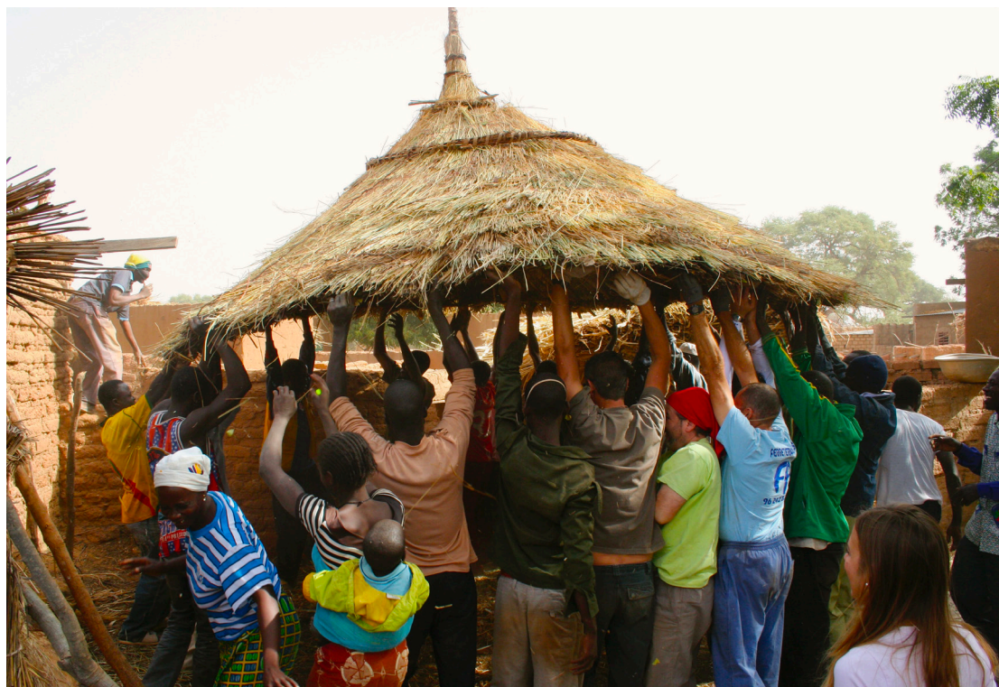
Fig.2.11. Proceso de construcción de una cubierta tradicional de paja en Baasneere en 2011. La imagen muestra el momento en que la cubierta es elevada por parientes y vecinos convocados y colocada sobre la muros previamente construidos de la nueva vivienda en la agrupación de una familia. Fuente: Xavi Ferragud.
