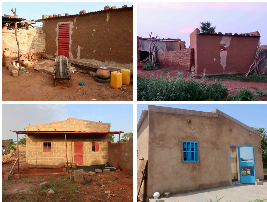
Fig.2.49. Empleo de cemento en morteros para las reparaciones puntuales en las viviendas de configuración tradicional, como bloque de tierra-cemento en la construcción de nuevas viviendas o como mortero de revestimiento para las construcciones más recientes.
