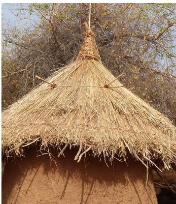
Fig.2.40. Diferentes soluciones de protección frente al viento en la ejecución de las cubiertas en las culturas lobi, gouin y kassena. Fuente: Fernando Vegas y Camilla Mileto.
