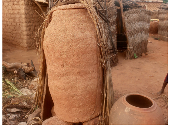
Fig.2.32. Graneros de paredes de banco en un patio en Baasneere. Este tipo de graneros se construían con tierra, a diferencia de los grandes recipientes de paja trenzada situados en los campos, por su tamaño más reducido y para protegerlos de los fuegos en el interior del patio.
