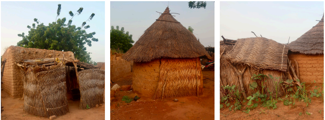
Fig.2.37. Distintos usos de las esteras de sêko como cerramientos, puertas y porches.
