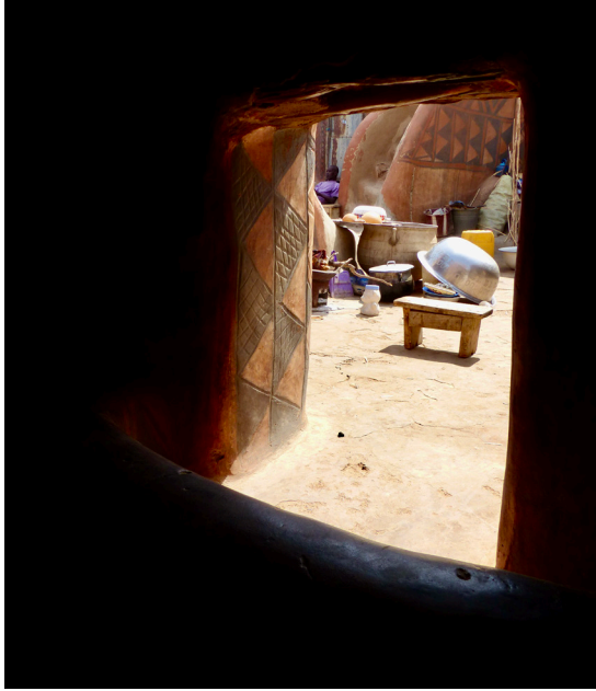
Fig.2.46. Accesos a la vivienda tradicional de una mujer kasserana en la Cour Royale de Tiébélé, donde es posible apreciar el muro bajo que protege la entrada. En la imagen que muestra la vista desde el interior se puede ver que el hueco se dispone de manera que el acceso al patio es visible desde dentro de la vivienda. Fuente de las fotografías: Fernando Vegas y Camilla Mileto.
