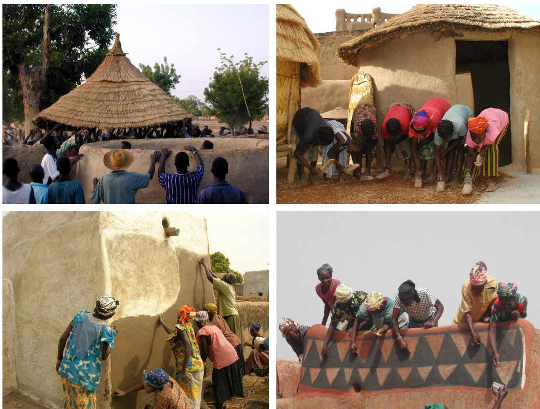
Fig.3.9. Proceso de renovación de cubiertas tradicionales de paja ( soukpilli ) y de elaboración de los suelos exteriores en el Na-Yiri de Kokologho (arriba). Realización de revestimientos tradicionales en la Cour Royale de Tiébélé (abajo). Fuente: CRAterre.
