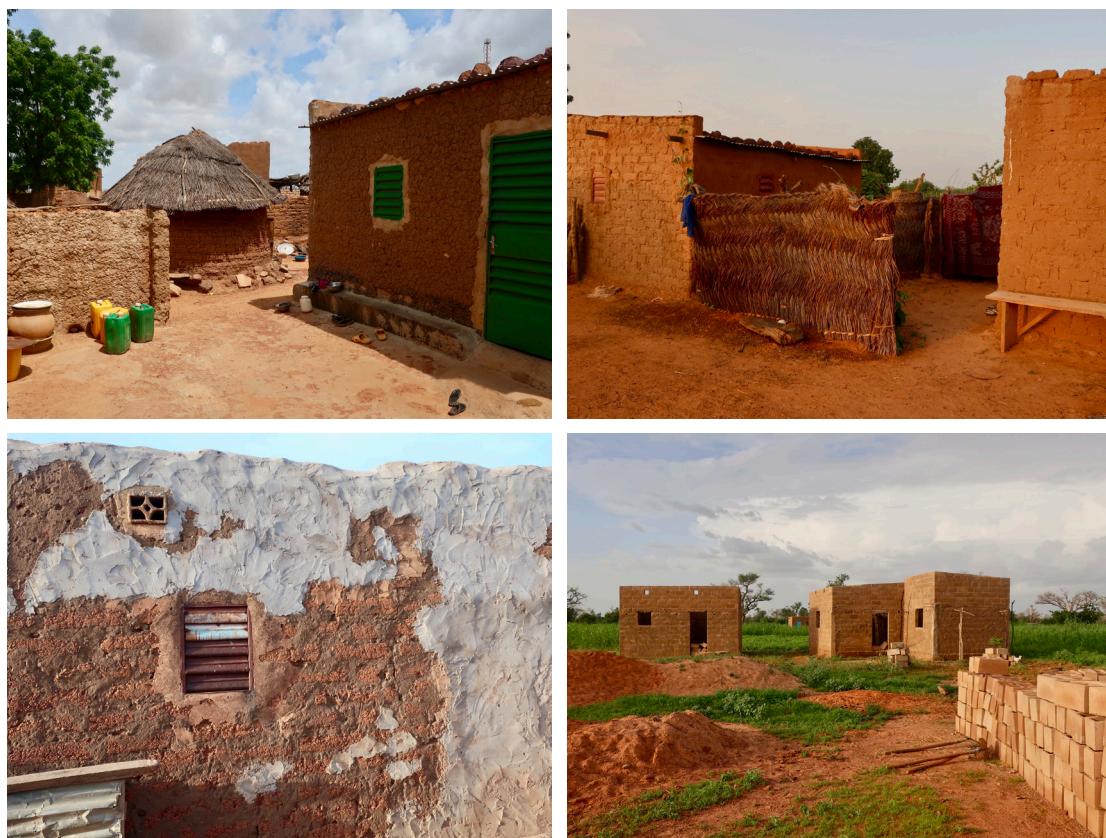
Fig.2.48. Transformaciones materiales según la importancia de su representación en el pueblo: uso mayoritario de chapa metálica ondulada en cubiertas y de carpinterías prefabricadas en huecos de puertas y ventanas, empleo menor de mortero de cemento en reparaciones y de bloques de tierra-cemento en reparaciones o en nuevas construcciones.
