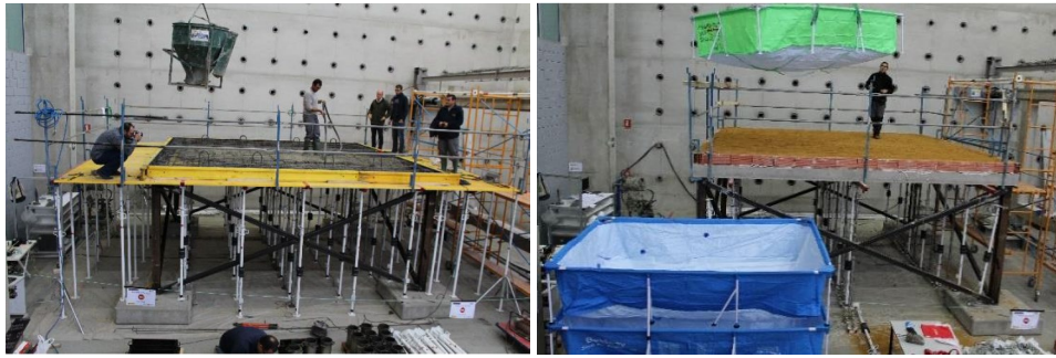
Figura 8. Hormigonado de la losa (izquierda) y disposición de la sobrecarga (derecha).
