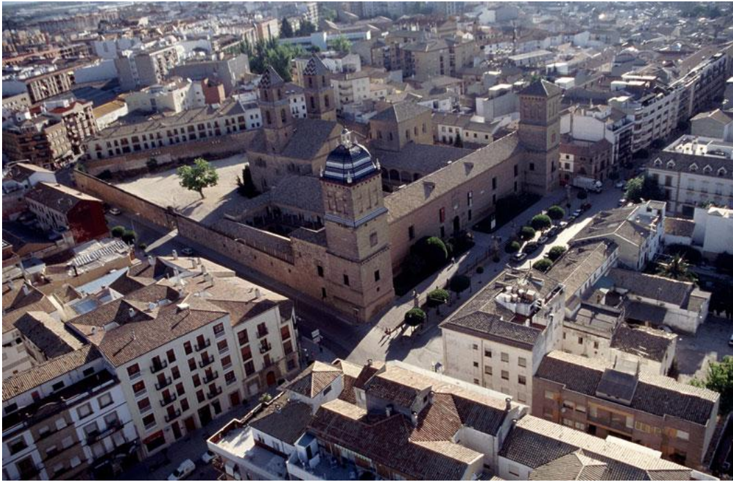
Fig. 61. Vista aérea del recinto del Hospital de Santiago.
