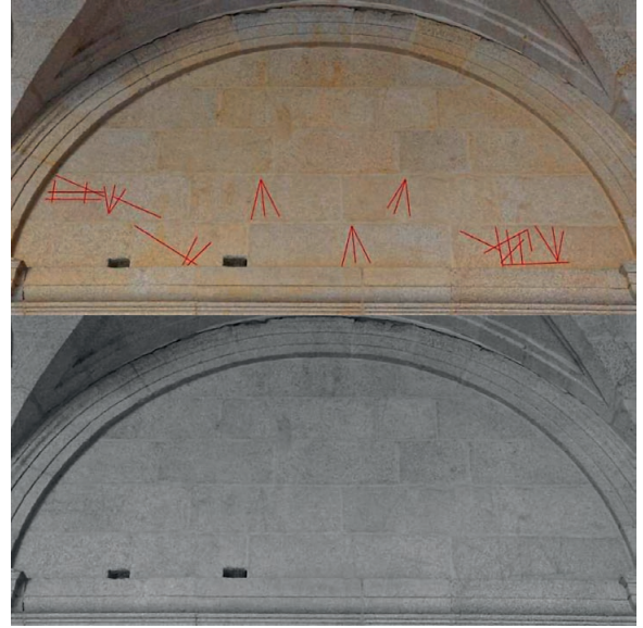
Figura 14. Trazados encontrados bajo las bóvedas. Crujía adyacente. Estado natural y remarcado.
