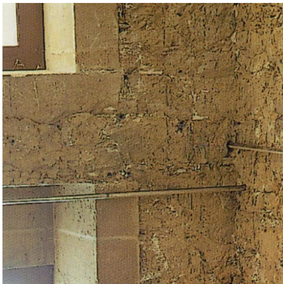
Figura 11. Interior de tapia del cañón de la escalera principal (Cortesía de la DXPC, Xunta de Galicia).
