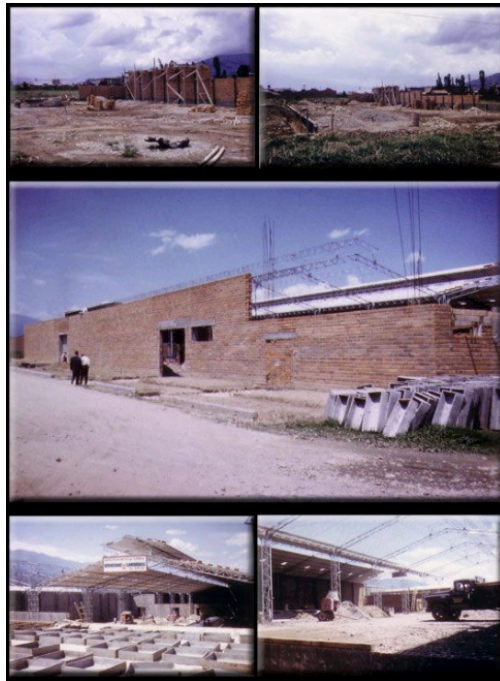
FIGURA 1.32. DISCOS FUENTES. CONSTRUCCIÓN DE LA NUEVA SEDE, MEDELLÍN (1960)
