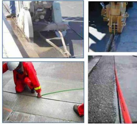
Imagen 6. Ejemplo de despliegue usando la microzanja.
