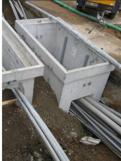
Imagen 3. Ejemplo de canalización subterránea
