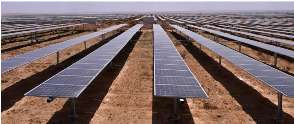
Ilustración 44. Fotografía de disposición de trackers, propiedad de GRUPOTEC.
