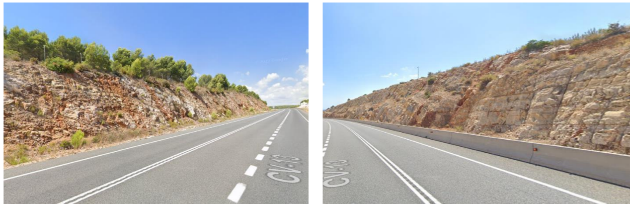
Ilustración 2. Taludes existentes sobre dolomías y margas de la Zona 4 (Fuente: Google)
