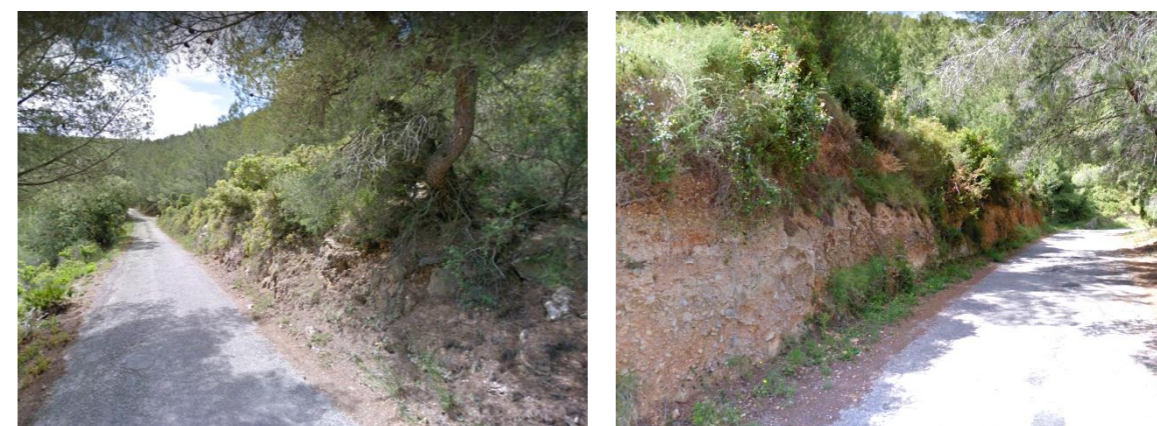
Ilustración 5. Taludes existentes sobre calizas bioconstruidas, calizas, margas y areniscas de la Zona 5 (Fuente: Google)
