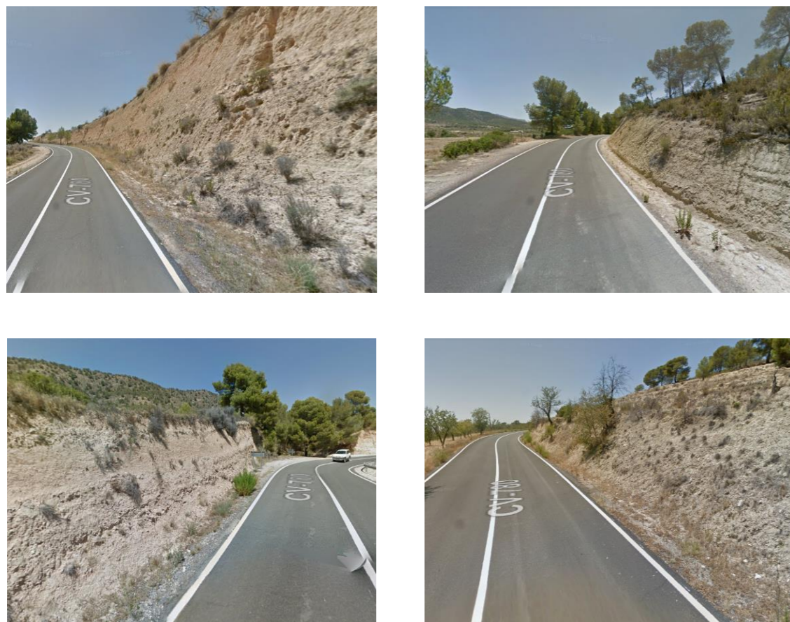
Ilustración 6. Taludes existentes sobre flysch, calizas fosilíferas y margas de la Zona 14 (Fuente: Google)
