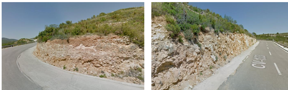
Ilustración 3. Taludes existentes sobre calizas bioconstruidas, calizas, margas y areniscas de la Zona 4 (Fuente: Google)
