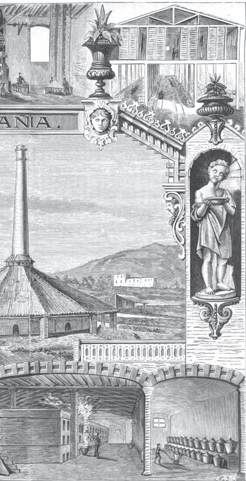
Vista general y detalles.)
