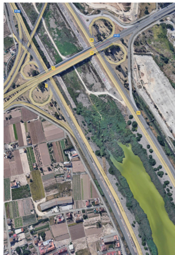
18 Nuevo Cauce, Castellar-L'Oliveral, Valencia, Google Earth (2022)
