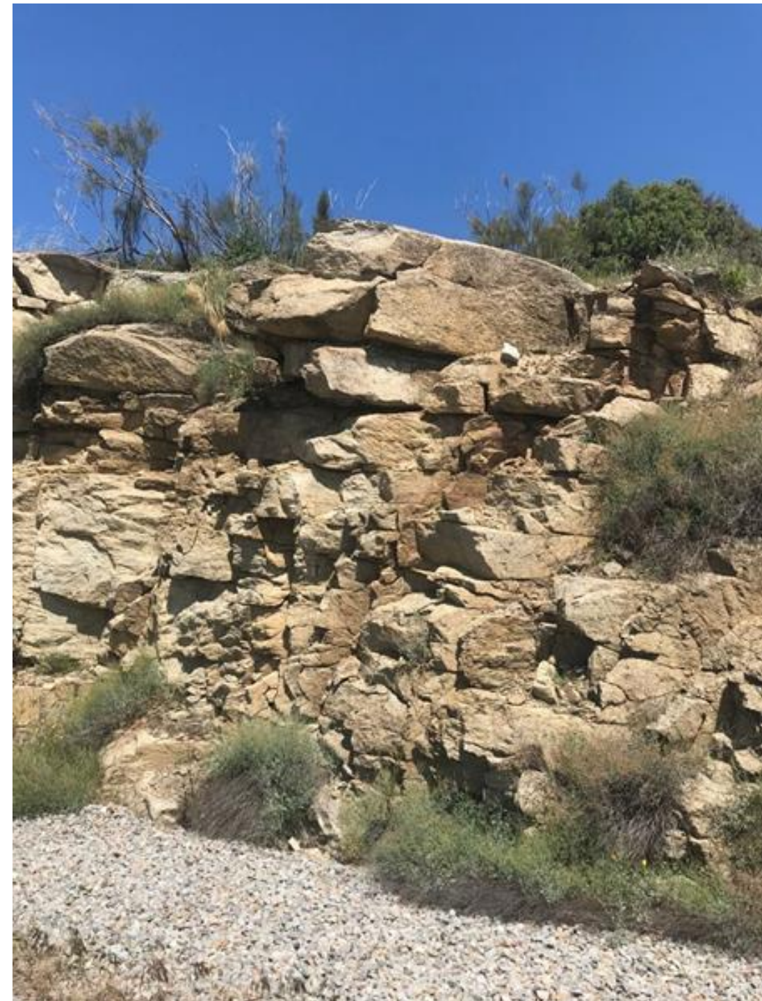
Figura 15 - Detalle estratificación en talud 5. Fuente: Elaboración propia.
