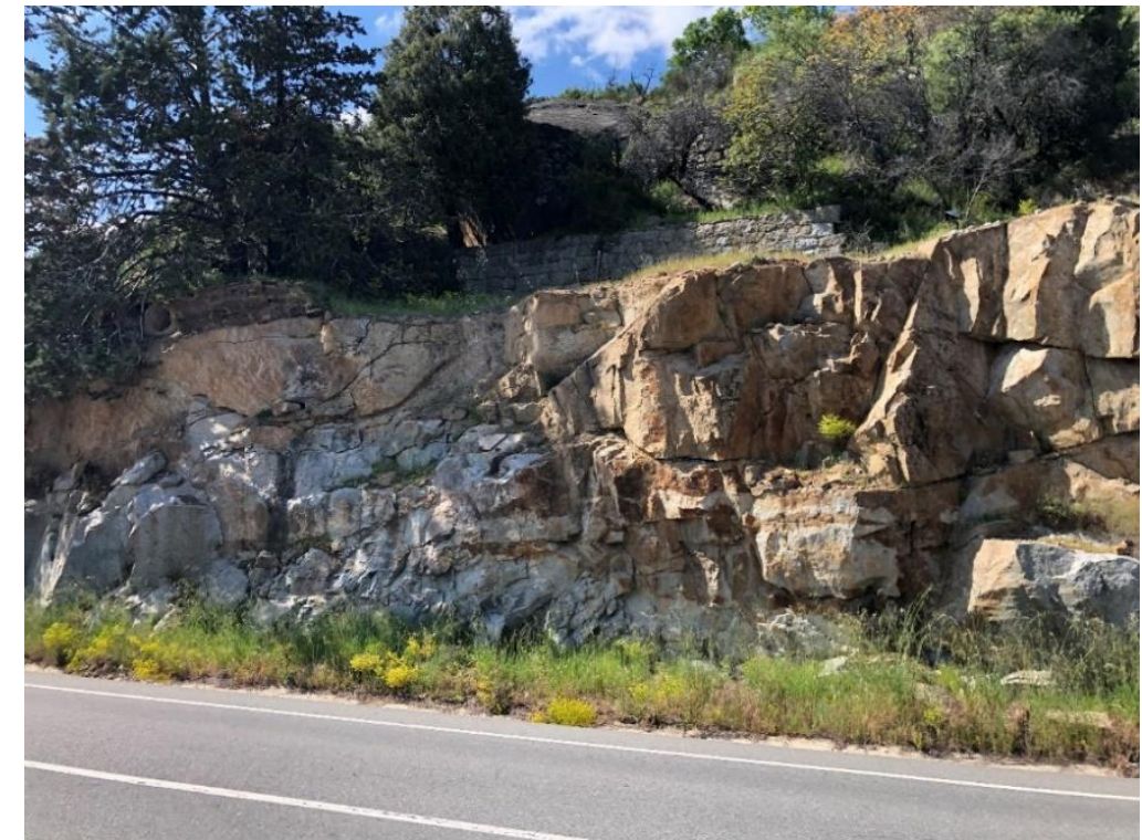
Figura 7 - Detalle bloques en cabeza de talud 2. Fuente: Elaboración propia.
