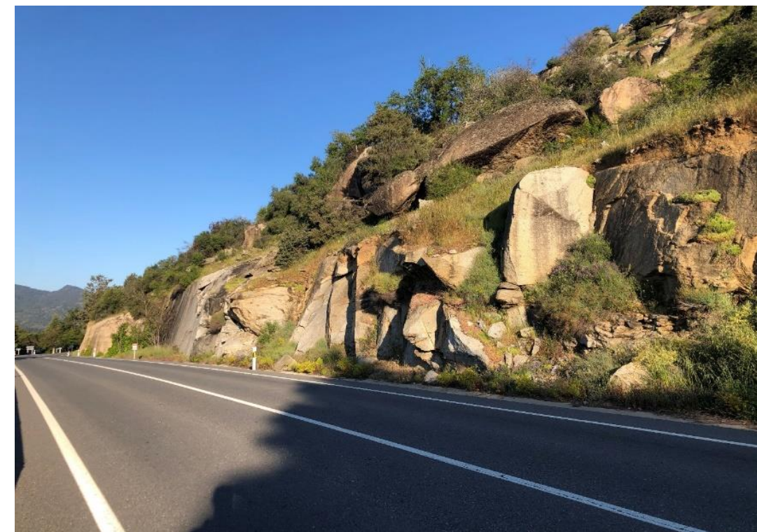
Figura 8 - Detalle tramo inicial del talud 3. Fuente: Elaboración propia.
