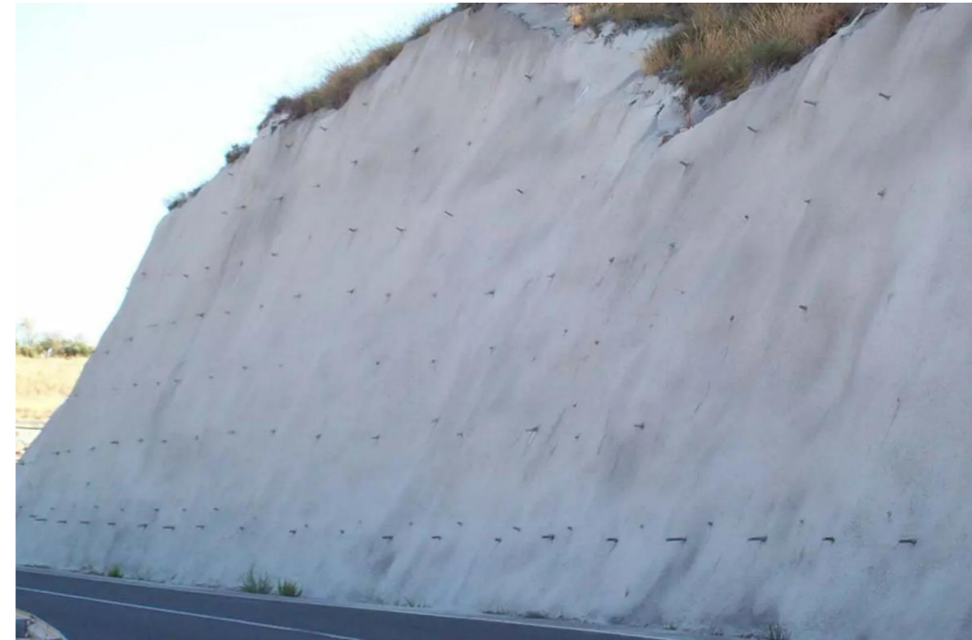
Figura 3 - Gunitado en talud. Fuente: Google imágenes.
