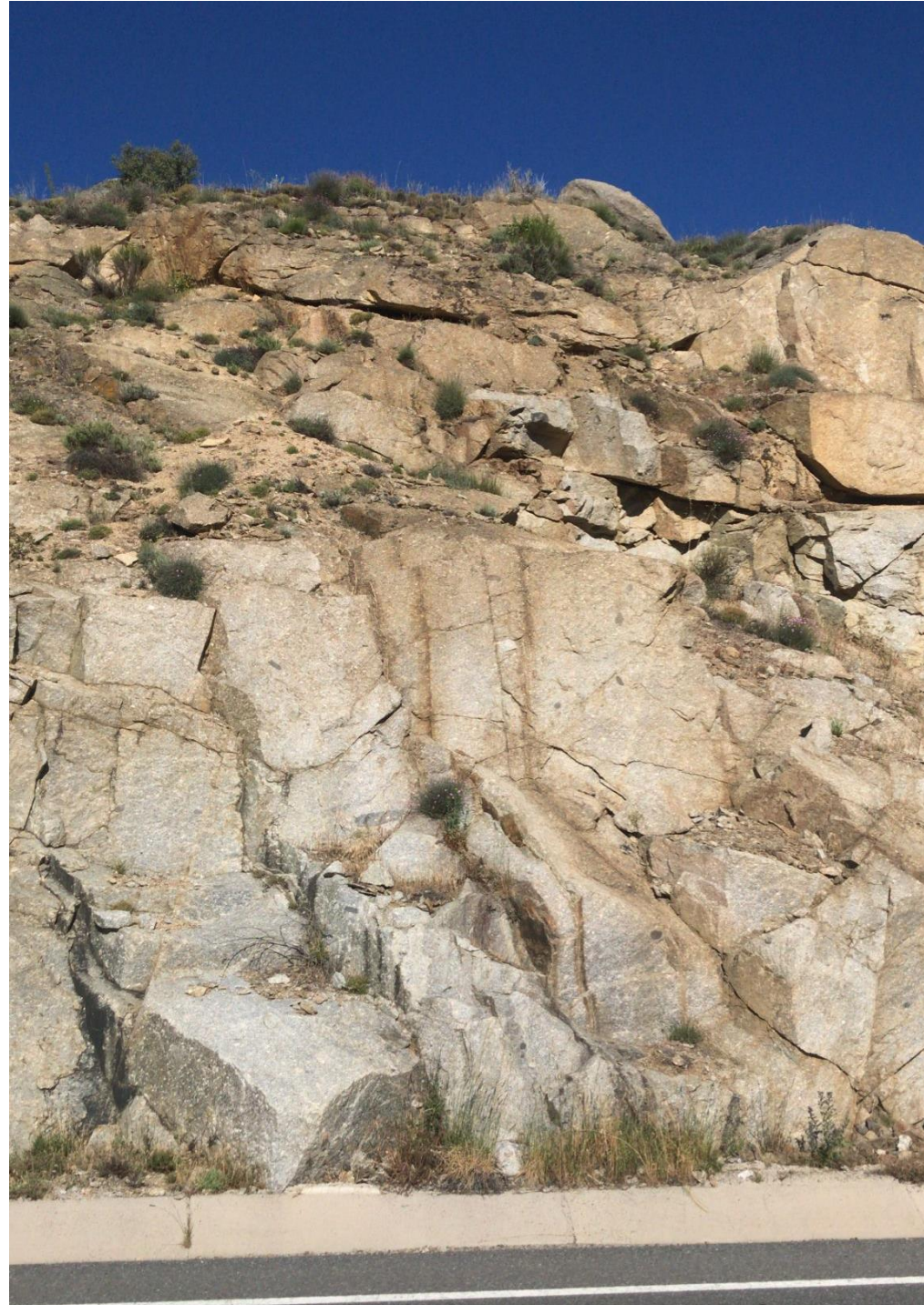
Figura 20 - Detalle bloques de tamaño medio en cabeza de talud. Fuente: Elaboración propia.
