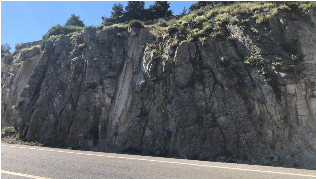
Figura 23 - Estratificación de talud 8. Fuente: Elaboración propia.
