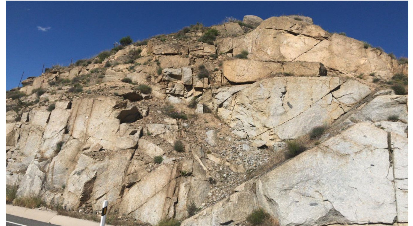
Figura 21 - Planos de rotura predominantes en talud 7. Fuente: Elaboración propia.
