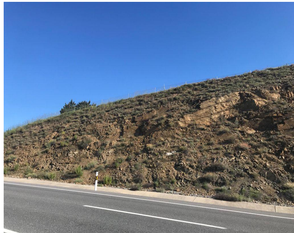
Figura 3 - Afloramientos de estratificación en talud 1. Fuente: Elaboración propia.
