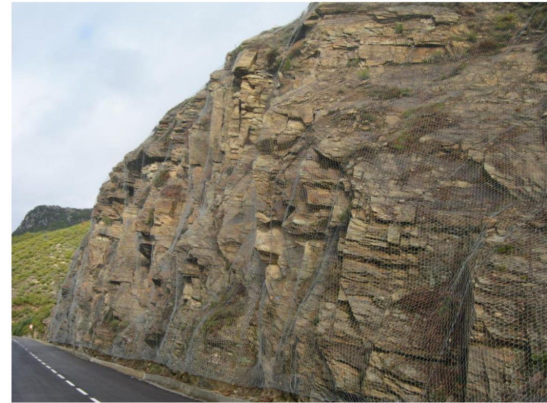
Figura 5 - Malla de triple torsión colgada o sistema Proactive. Fuente: Paramassi.
