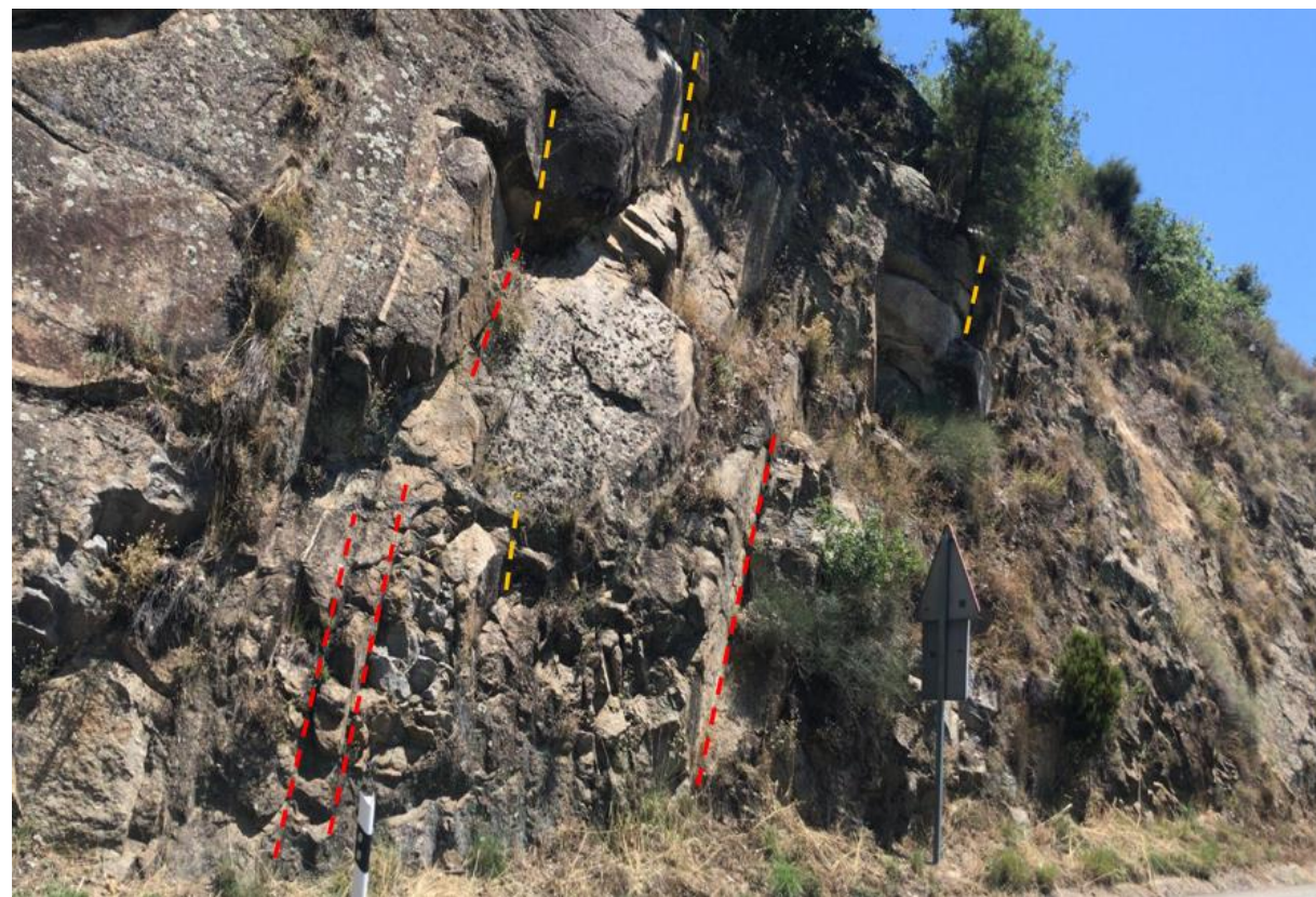
Figura 38 – Familias de discontinuidades. Fuente: Propia.
