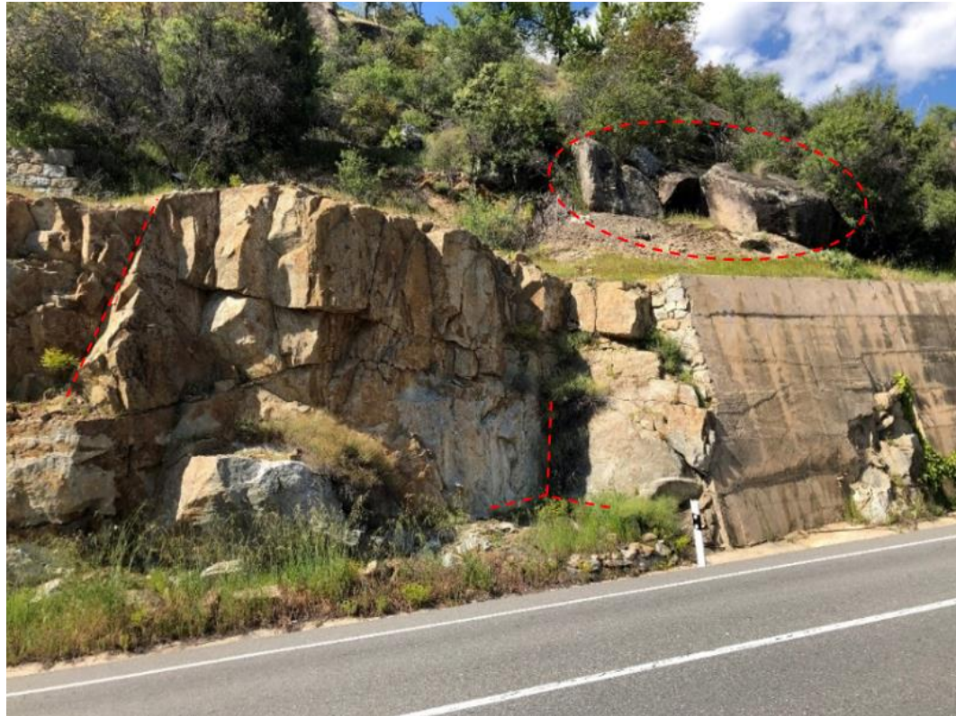
Figura 4 – Bloques en cabeza. Familias de discontinuidades. Plano de rotura planar y deslizamiento. Pie de talud de tamaño limitado. . Fuente: Propia.
