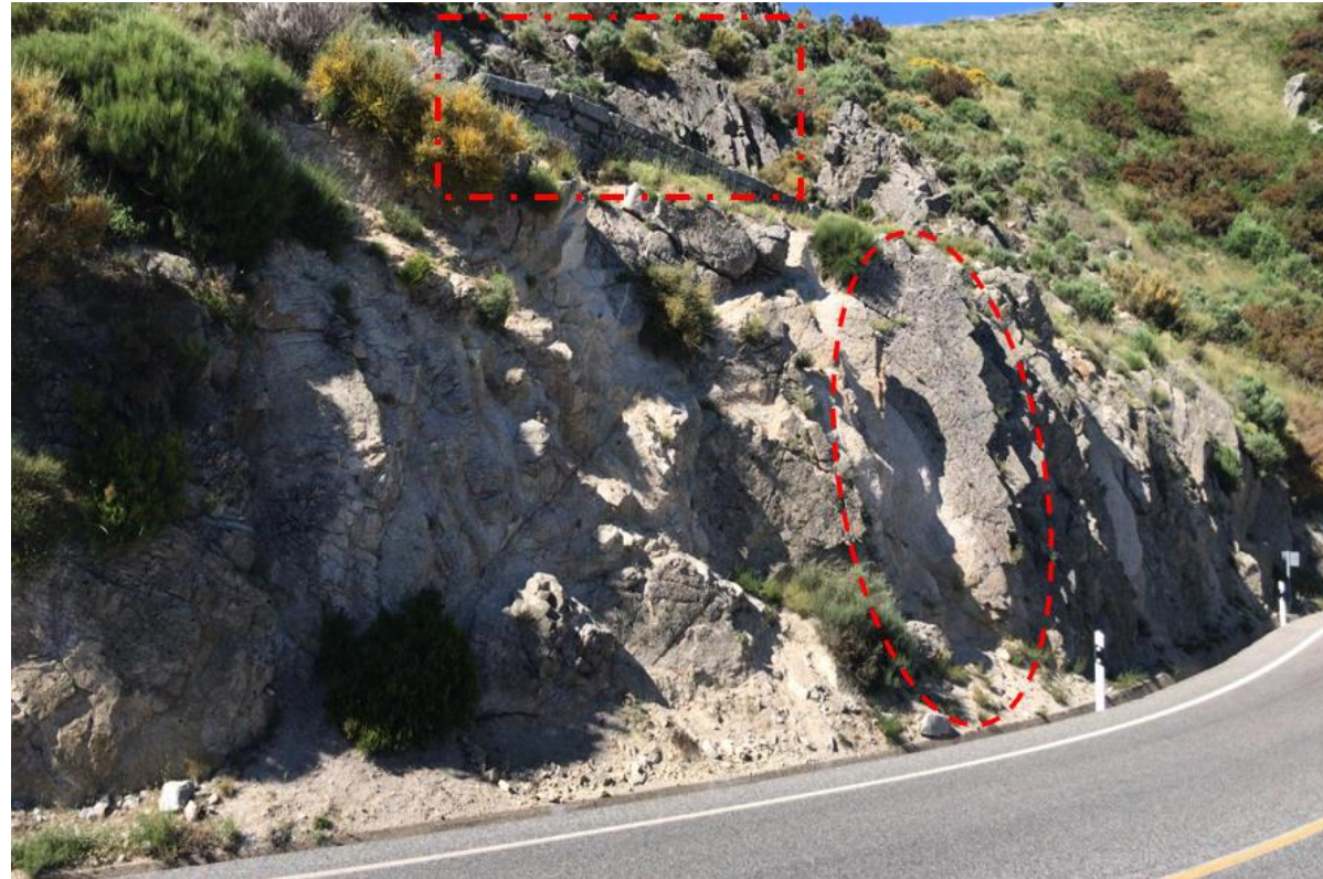
Figura 22 – Talud en curva. Zona de reguero de agua. Muro en cabeza de talud. Fuente: Propia.
