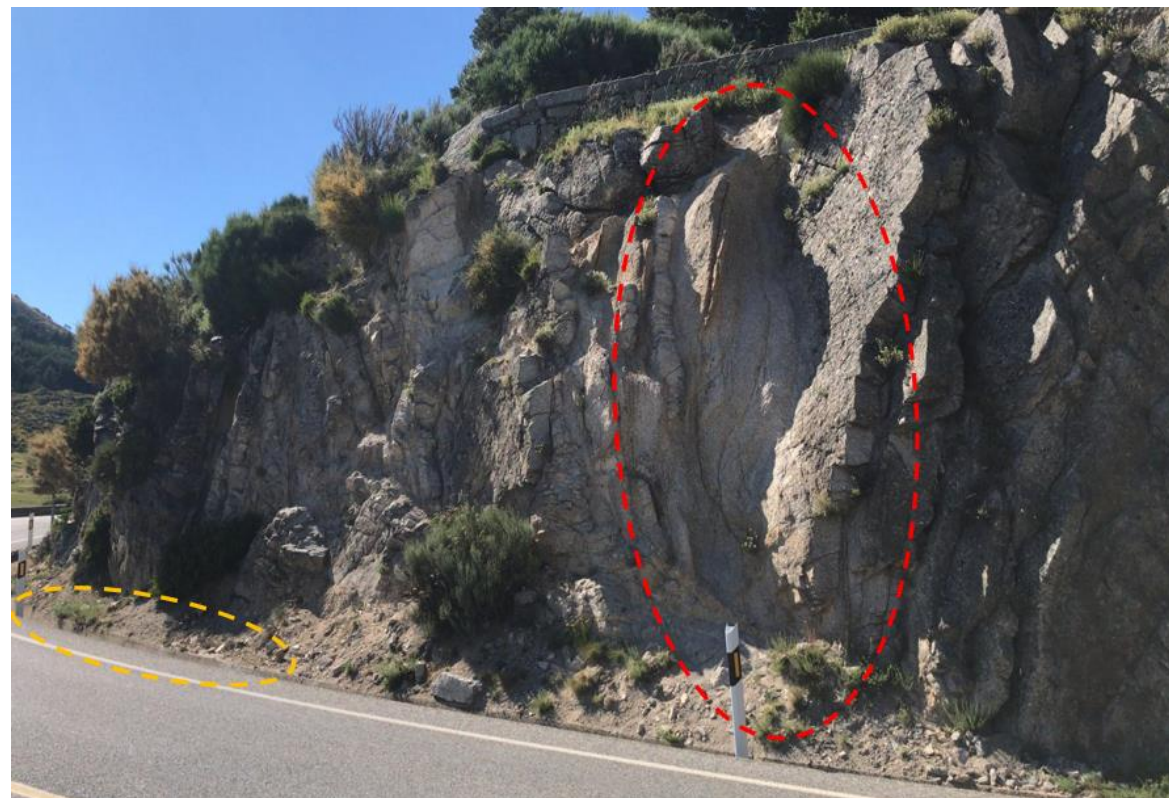
Figura 23 – Detalle de cuneta de pie de talud. Zona de reguero de agua. Talud en curva. Fuente: Propia.
