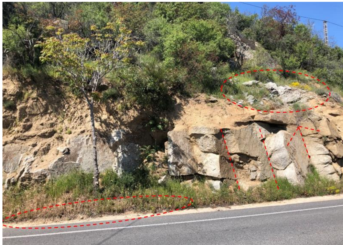
Figura 11 – Familias de discontinuidades. Bloques inestables en cabeza de talud. Berma de pie de talud de tamaño reducido. Fuente: Propia.
