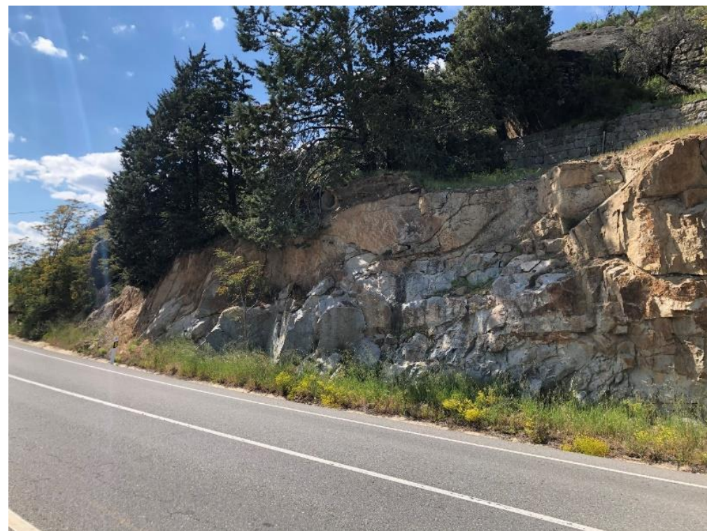
Figura 6 - Detalle tramo final del talud 2. Fuente: Elaboración propia.
