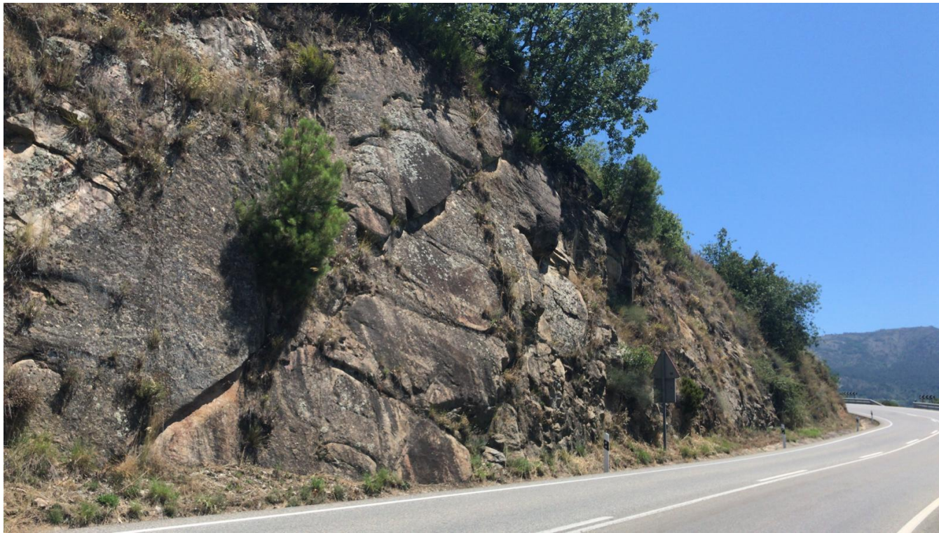
Figura 31 - Detalle de talud de proximidad a curva. Fuente: Elaboración propia.
