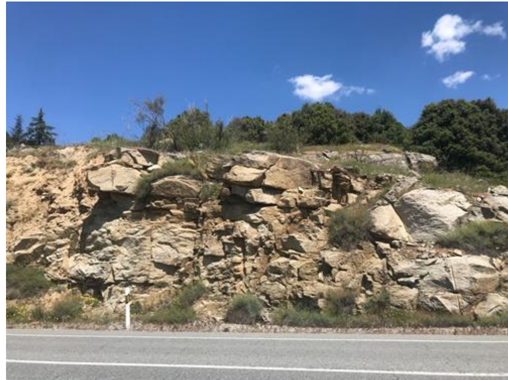
Figura 13 - Zonta central del talud 5. Fuente: Elaboración propia.
