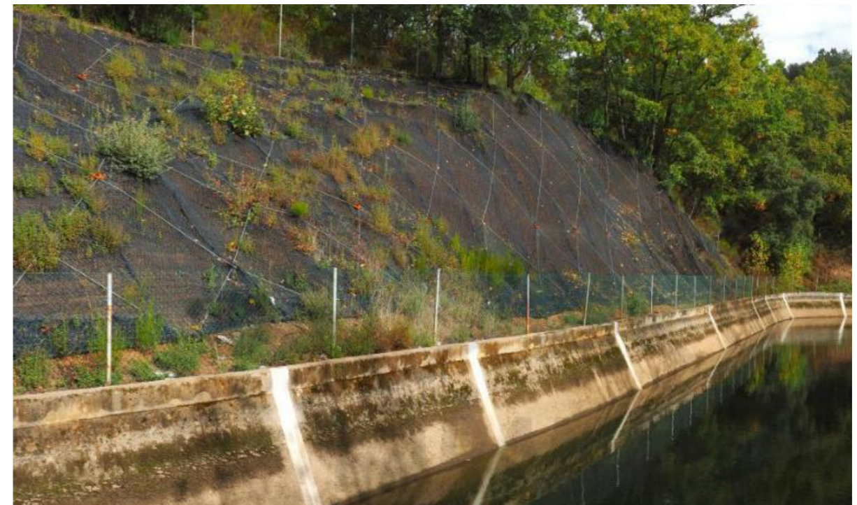
Figura 9 - Sistema K-MAT Reforzada. Fuente: Paramassi.
