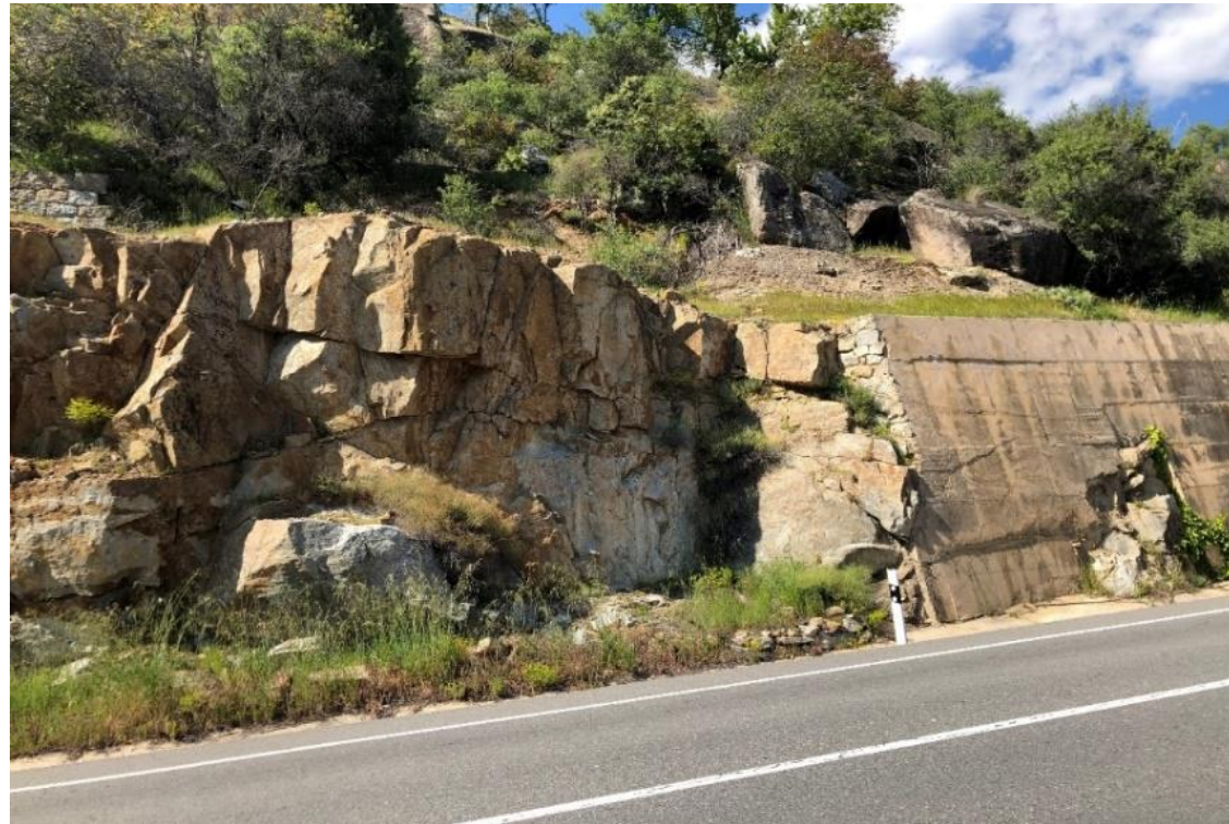
Figura 5 - Detalle tramo inicial del talud 2. Fuente: Elaboración propia.
