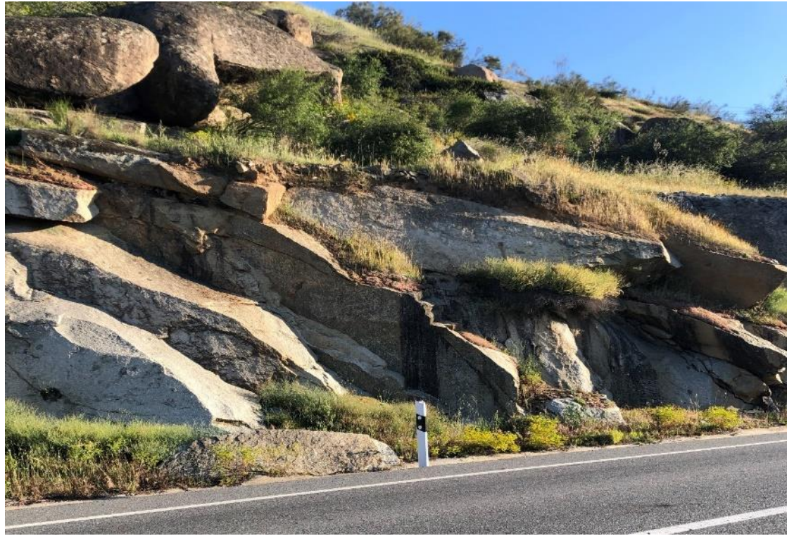
Figura 9 - Estratificación en el talud 3. fuente: Elaboración propia.
